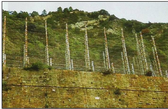
a) formada por postes e redes metálicas
