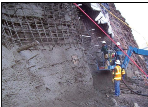
Figura 4.11 – Aplicação de betão projectado com fibras (Andrew et al. , 2011)
