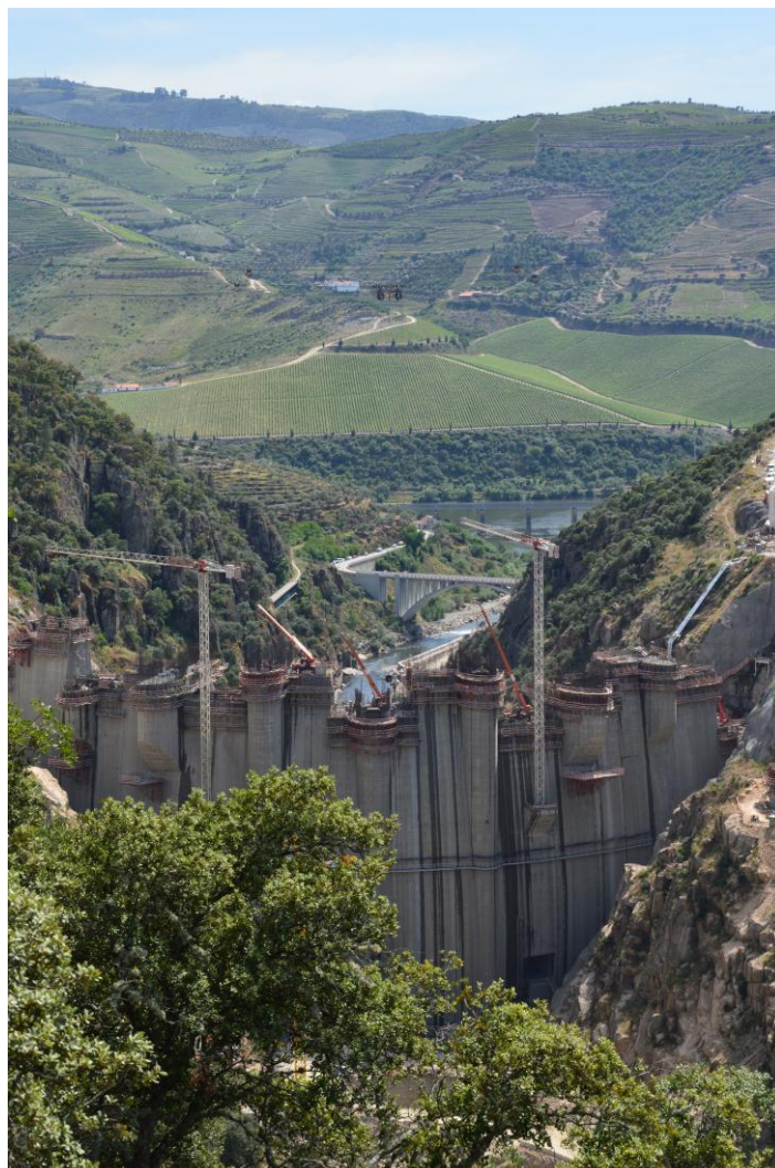
Figura 4.16 - Construção da barragem de Foz Tua.
