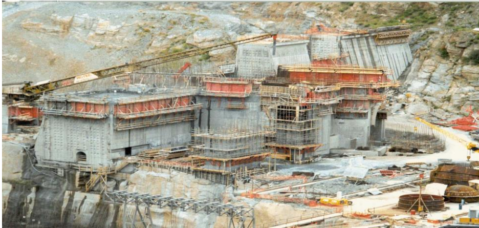
Figura 2.2 - Betonagem de um bloco de barragem com recurso a tapete transportador
