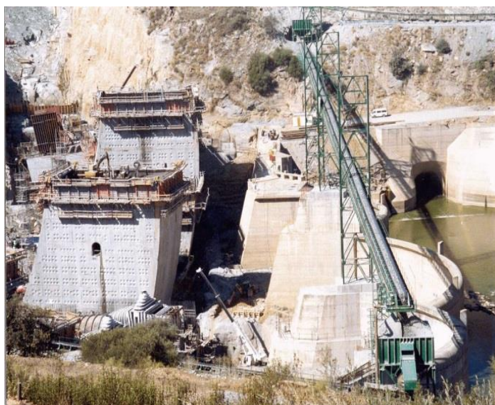
Figura 2.1 – Betão em massa em blocos de barragem
