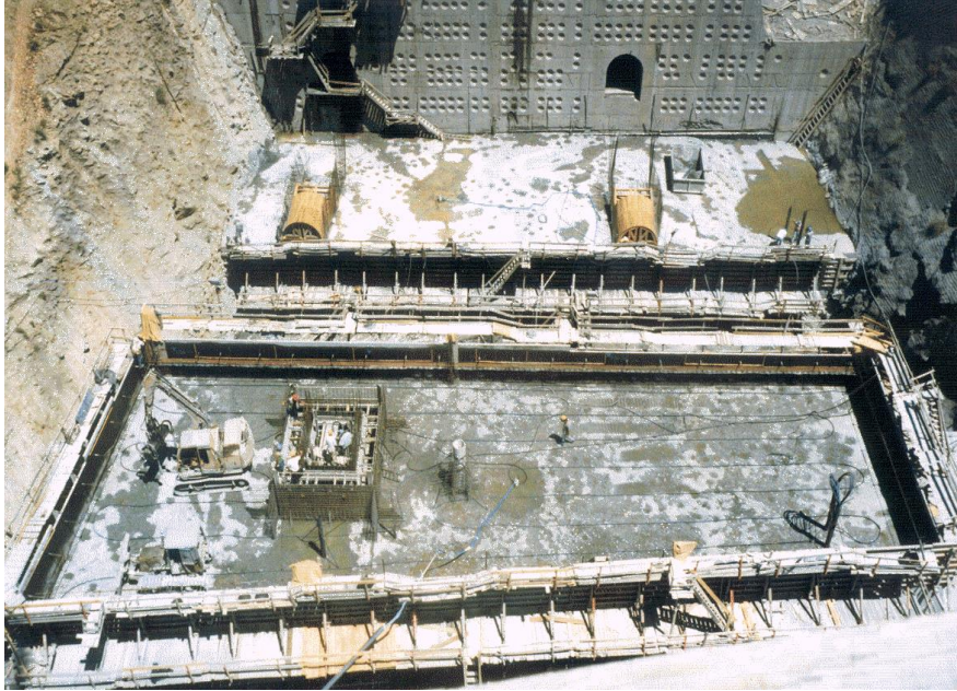
Figura 6.17 - Serpentina de refrigeração e chaminé interior – preparação de bloco para betonagem
