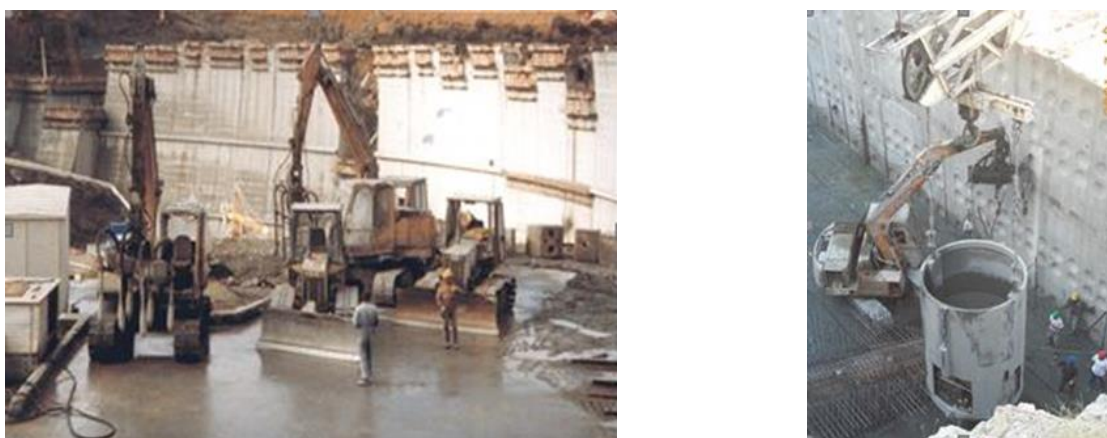
Figura 3.7 - Equipamento para colocação, distribuição e compactação de betão em massa
