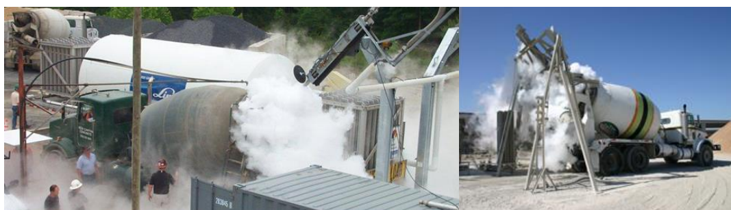
Figura 5.1 - Injecção de azoto líquido (GADJA e SUMODJO, 2012)
