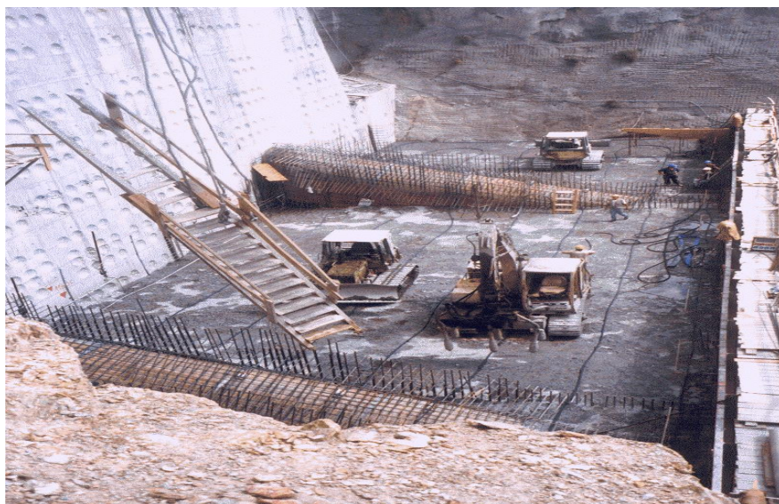
Figura 6.18 - Serpentina de refrigeração – preparação de bloco para betonagem
