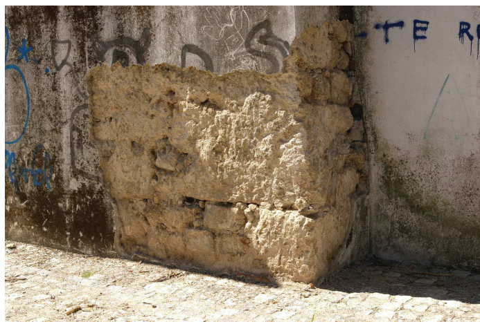
Fig. 43 – Pormenor do aparelho construtivo dos contrafortes junto à capela-mor Foto: Carlos Boavida
