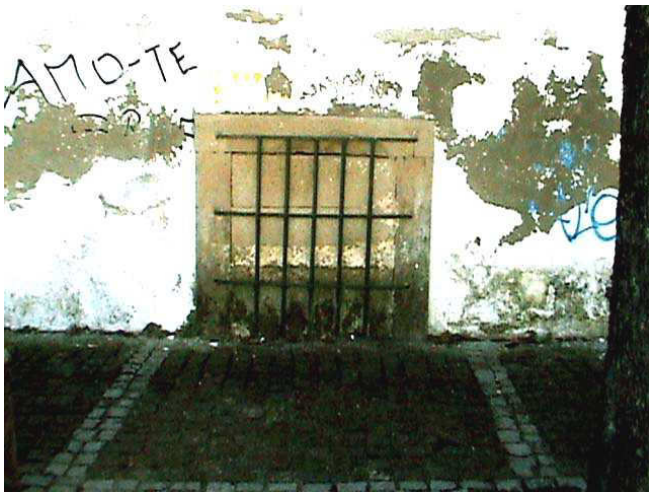
Fig. 40 – Pormenor de janela entaipada nessa fachada Foto: Carlos Boavida
