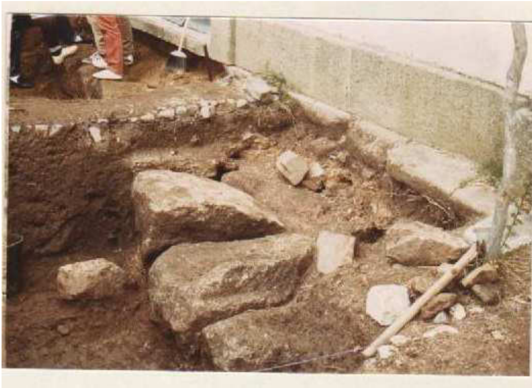
Fig. 55 – Estrutura ou eventual derrube dessa, fente à fachada principal da Igreja (original cedido por João Henriques Ribeiro)
