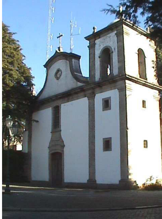
Fig. 38 – Vista geral da fachada principal da Igreja de Santa Maria do Castelo Foto: Carlos Boavida
