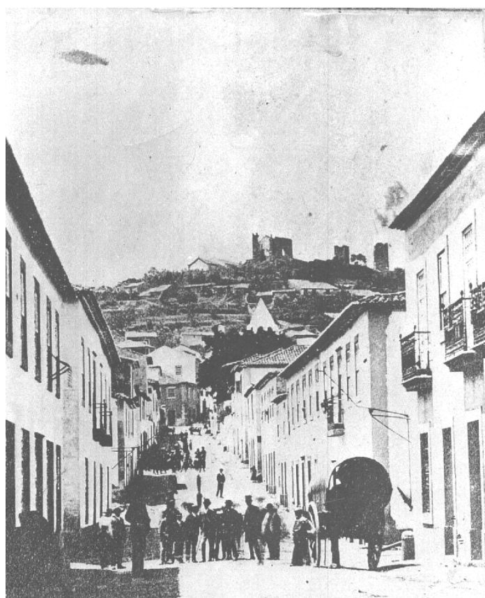
Fig. 22 – Castelo de Castelo Branco visto a partir da Rua do Pina – inícios século XX (?) Arquivo da Direcção-Geral de Edifícios e Monumentos Nacionais
