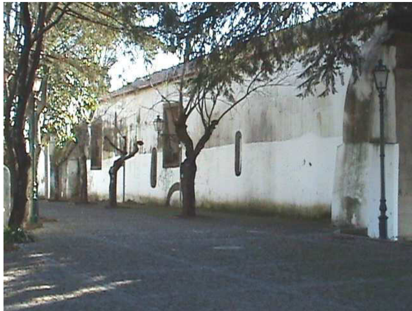
Fig. 39 – Fachada lateral aterrada, virada a norte Foto: Carlos Boavida
