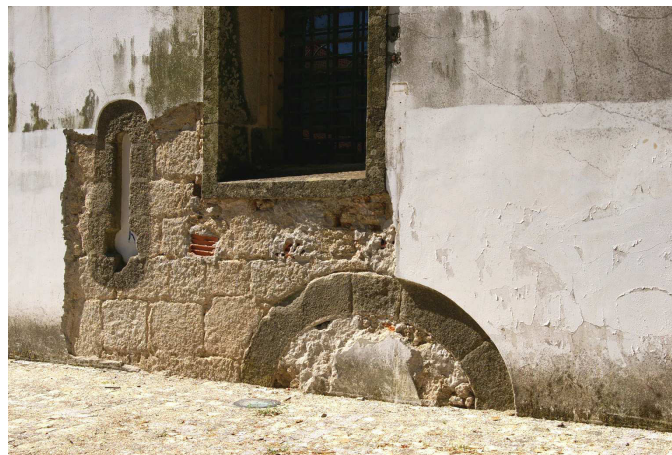
Fig. 42 – Pormenor dessa fachada, vendo-se o arranque da porta lateral e a troneira Foto: Carlos Boavida
