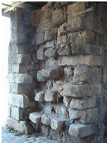
Fig. 34 – Pormenor do aparelho construtivo do torreão que integrava o Palácio dos Alcaides
