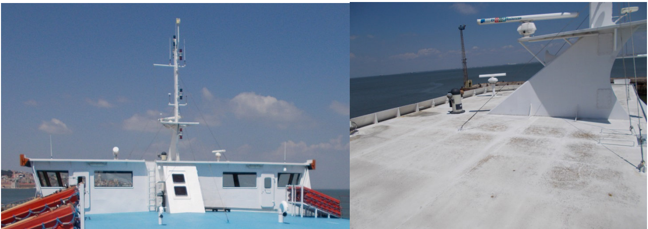
Figura 5.4 – Tecto da Ponte.
