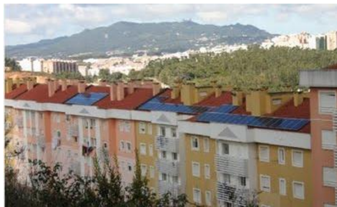
Figura 2.44 - Unidades de microgeração instaladas no
