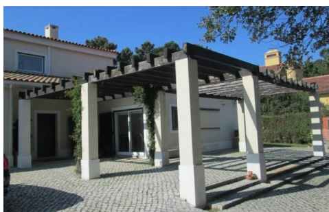
Figura 4.1 - Vista da fachada principal do edifício de habitação.
