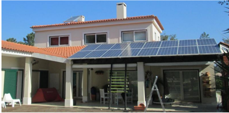
Figura 1 - Unidade de microgeração constituída por 16 módulos fotovoltaicos.
