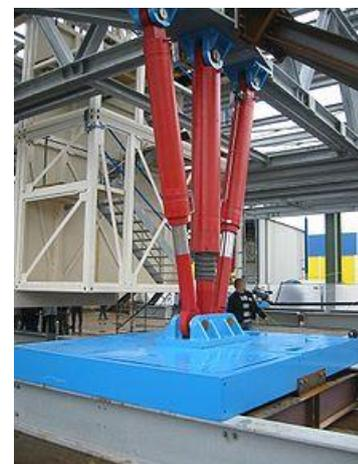
FIGURA 3-1 - "NEUMAYER STATION III" E O CONJUNTO DE HIDRÁULICOS QUE CONSTITUI UM DOS APOIOS DA ESTRUTURA
