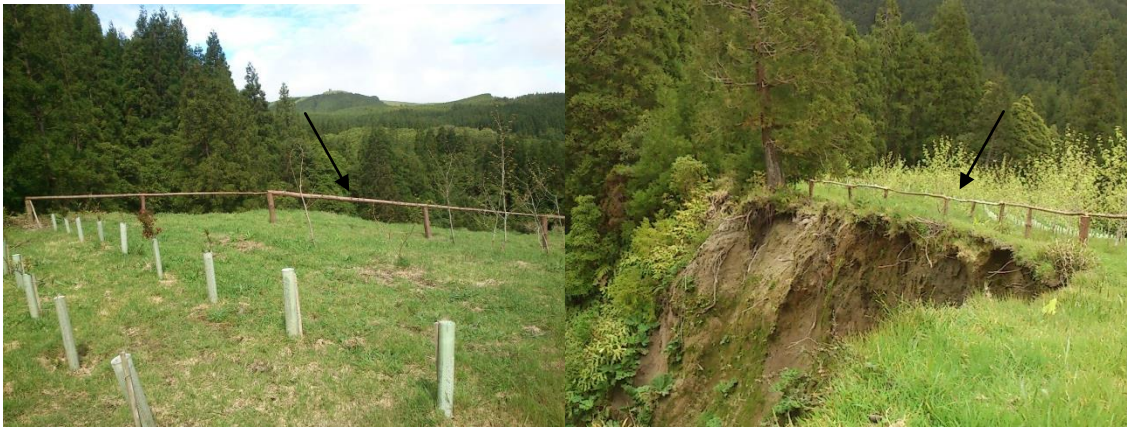
Figura 5.12 - Estrutura de proteção construída na proximidade do escorregamento identificado na parcela 38 B (25/04/14)
