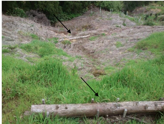
Figura 5.6 - Dissipadores de energia ( Pittosporum undulatum ) construídos a montante da ravina RB 6, na parcela 39 B (10/01/14)
