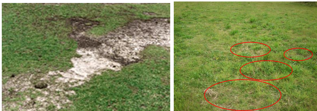
Figura 3.12 – À esquerda, um exemplo de um caso de erosão laminar (Landcarevic, 2014); à direita, erosão laminar observada na área de estudo (Vanzinho) com zonas um pouco mais profundas relativamente ao meio envolvente (26/04/2014)
