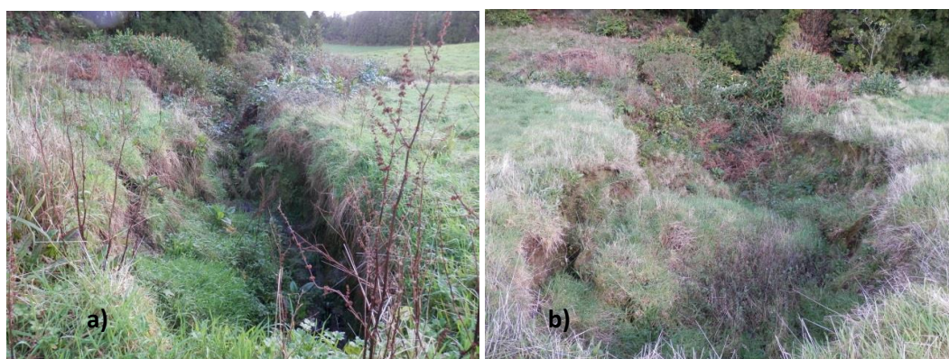
Figura 4.3- Ravinas/barrancos identificados na zona NW da área de estudo. a) RB 1; b) RB 2 (27/12/13)
