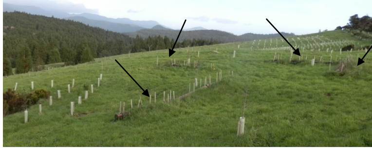
Figura 5.3 - Dissipadores de energia em forma de V, construídos a montante da ravina RB 10, na parcela 38 B (10/01/14)
