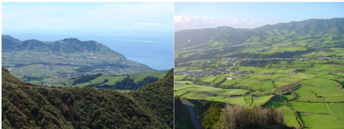
Figura 2.7 - Vista geral do Vulcão da Povoação de NW para SE (esquerda) e de E para W (direita) (fotografias de Coutinho in Cordeiro, 2011)
