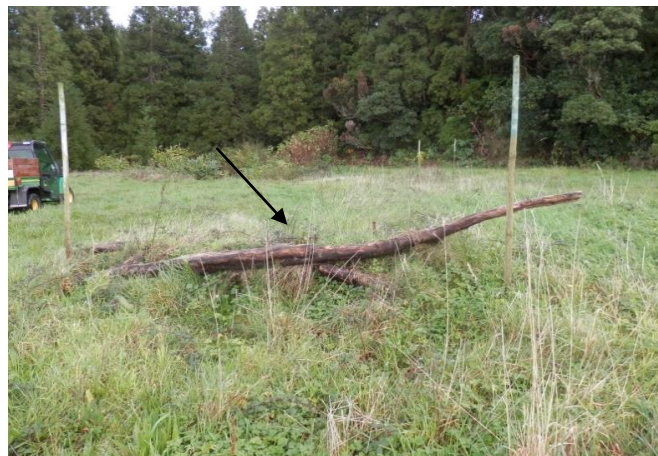
Figura 5.5 - Dissipadores de energia construídos a montante da ravina RB 4, no Vanzinho (10/01/14)
