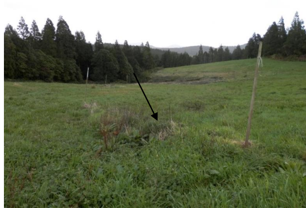
Figura 5.4 - Dissipadores de energia construídos a montante da ravina RB 3, no Vanzinho (10/01/14)
