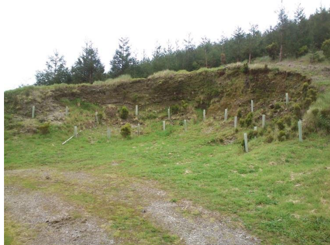
Figura 4.10 - Ravina/barranco identificada na parcela 39 G (RB 15), sem intervenção (10/01/14)
