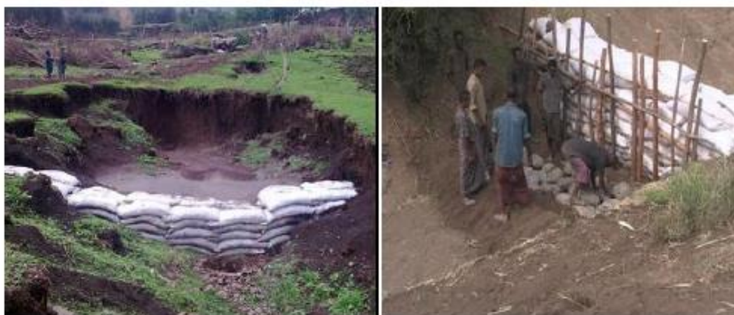
Figura 3.31 - Sacos de areia a funcionarem como um dique ou barragem de controlo de uma ravina (Desta & Adugna, 2012)
