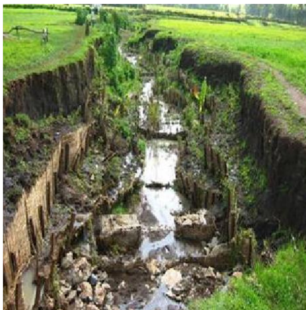
Figura 3.38 - Proteção das margens laterais de uma ravina com paredes de bambu (Desta & Adugna, 2012)
