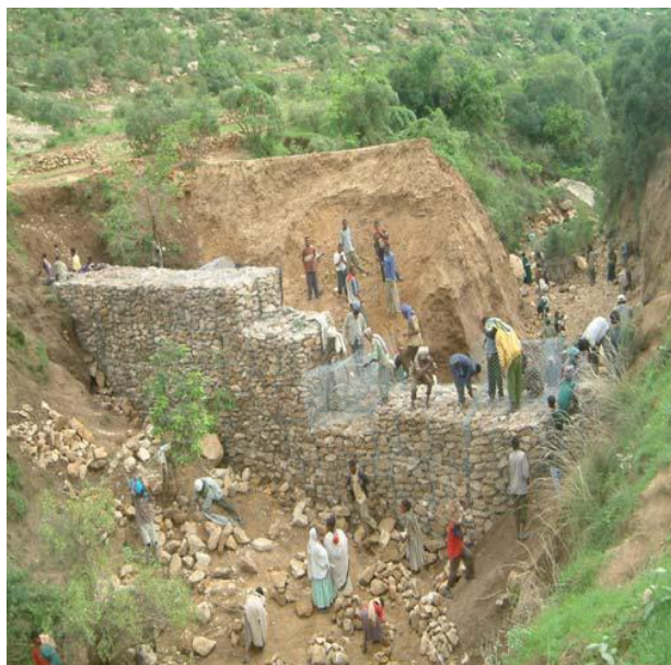
Figura 3.30 - Construção de uma barragem de controlo de gabiões (Desta & Adugna, 2012)
