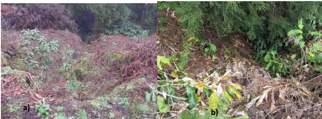
Figura 4.6 - Ravina/barranco identificada na parcela 39 B. a) RB 6; b) RB 7. Dissipadores de energia a montante (não visíveis na figura) com troncos de incenso ( Pittosporum undulatum ) (10/01/14)
