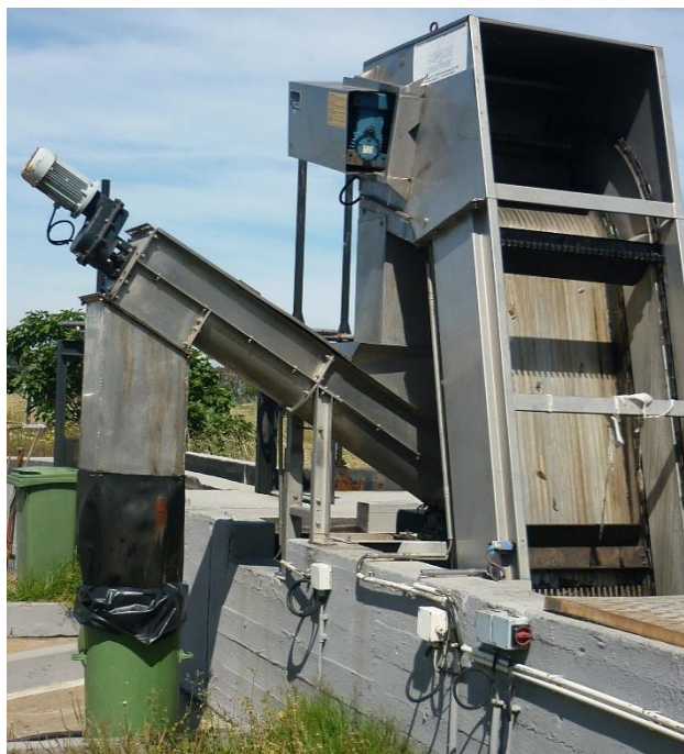
Figura 4.2 – Grade grossa mecânica e respectivo parafuso transportador
