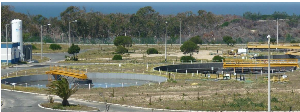
Figura 4.8 – Vista aérea dos 2 decantadores primários
