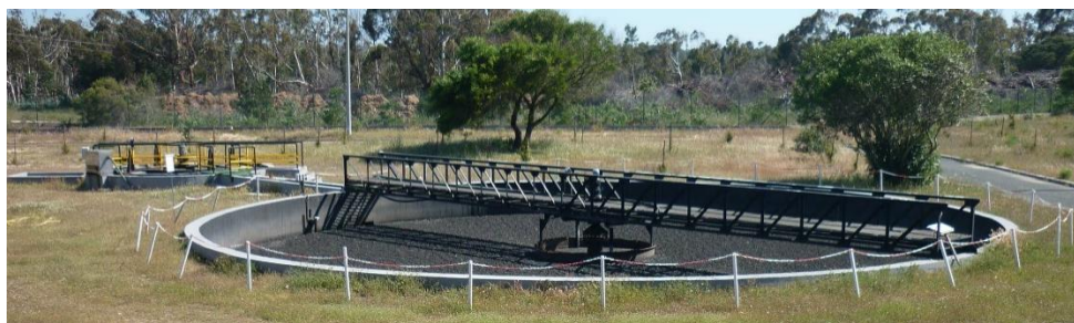
Figura 4.12 – Espessador gravítico
