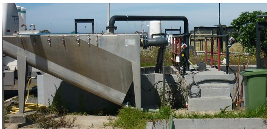
Figura 4.3 – Classificador de areias (à esquerda) e desarenador (à direita)
