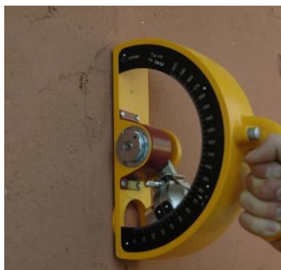
Figura 8.42 – Ensaio de resistência superficial com esclerómetro pendular num reboco
