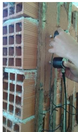
Figura 9.27 – Ensaio de velocidade de propagação de ultrassons sobre faixas de rebocos de argamassa no murete de tijolo
