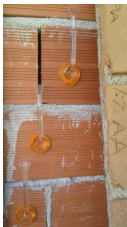
Figura 8.1 – Aplicação dos tubos de Karsten sobre os tijolos do murete de tijolo furado
