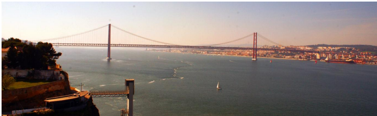
Figura 7.43 - Ponte 25 de Abril, vista para Lisboa.
