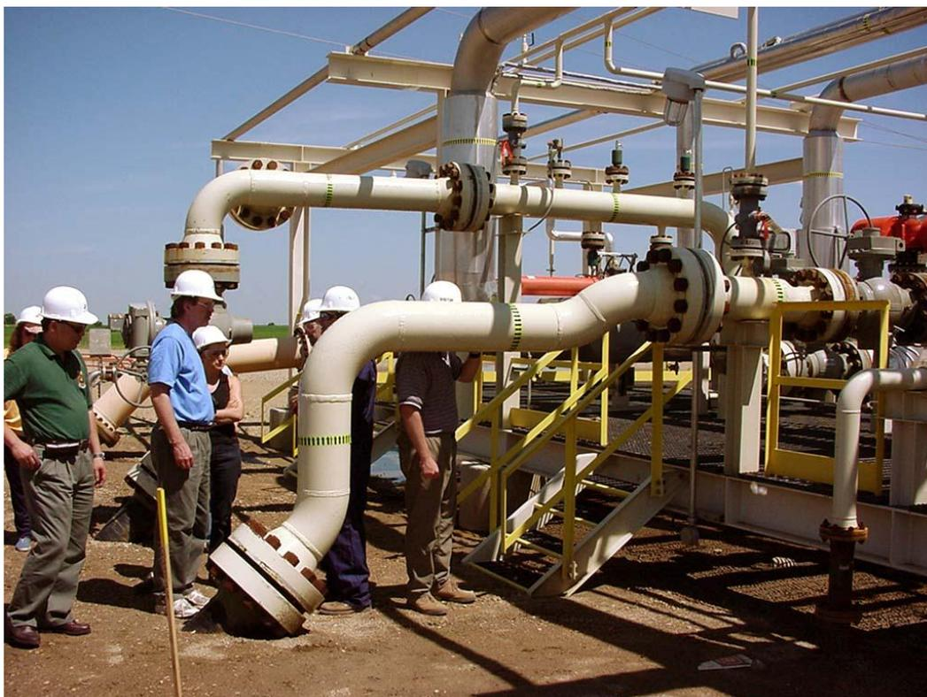
Figura 5.3 – Sistema de transporte de CO<sub>2</sub> por gasoduto (Princeton website)
