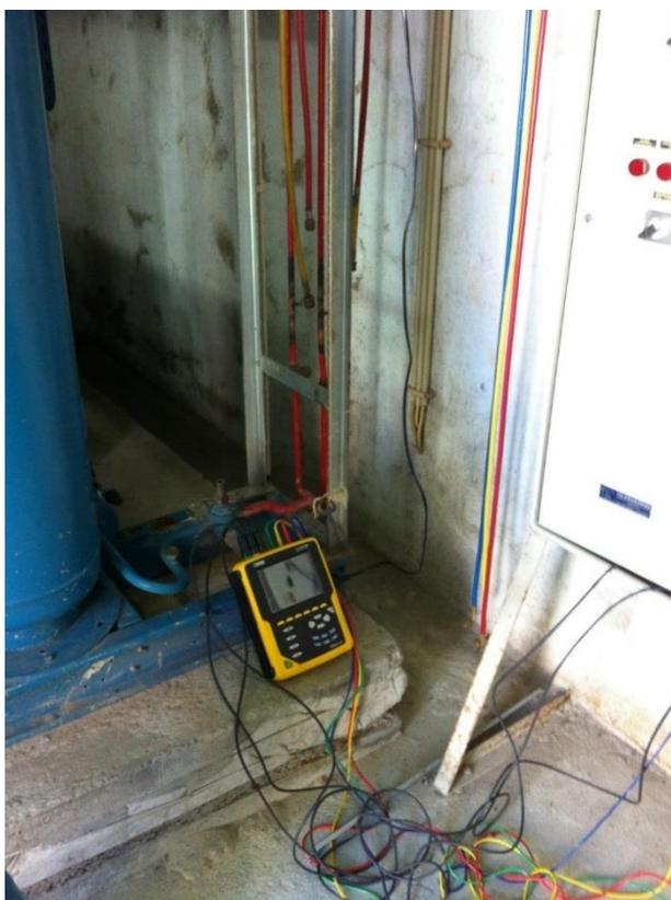
Figura 4.6 – Recolha de dados do perfil de consumo da central de frio do CFPSA
