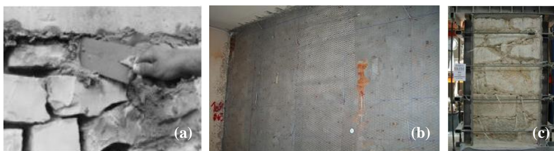
(a) - Refechamento de juntas (ALMEIDA et al 2011), (b) - Reboco armado (MAURÍCIO, 2012), (c) - injeção de calda em modelo de alvenaria de pedra irregular (APPLETON, 2003)
