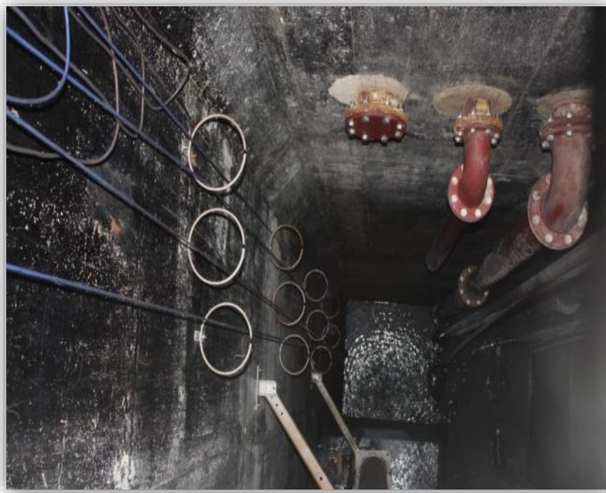
Figura 3.9 – Vista do poço de bombagem da instalação elevatória EE1
