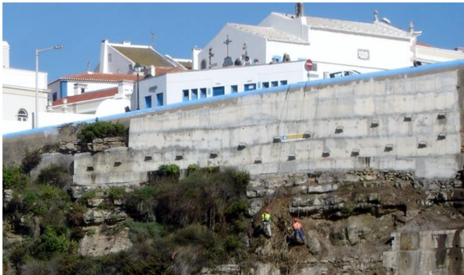
Figura 3.11: Muro em betão armado ancorado
