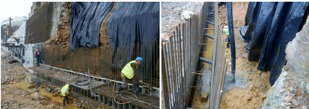
Figura 4.25: Alinhamento do novo muro no troço rompido
