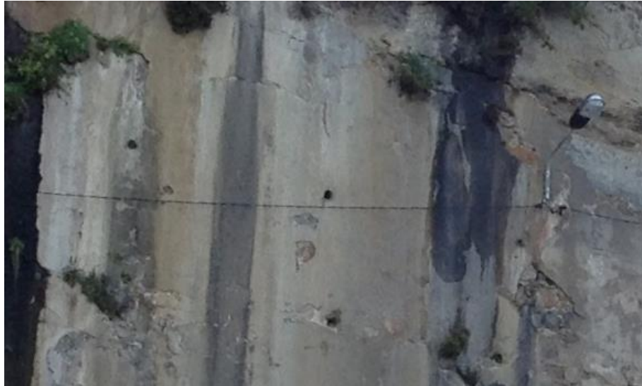
Figura 3.22: Pormenor dos furos de drenagem original da arriba
