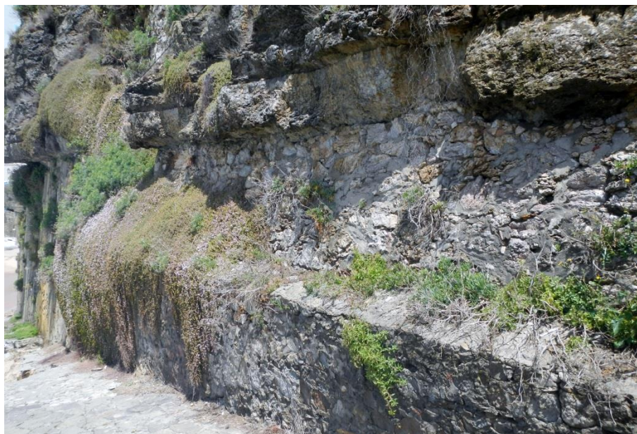
Figura 3.21: Revestimento da arriba sobre a rampa antes da intervenção
