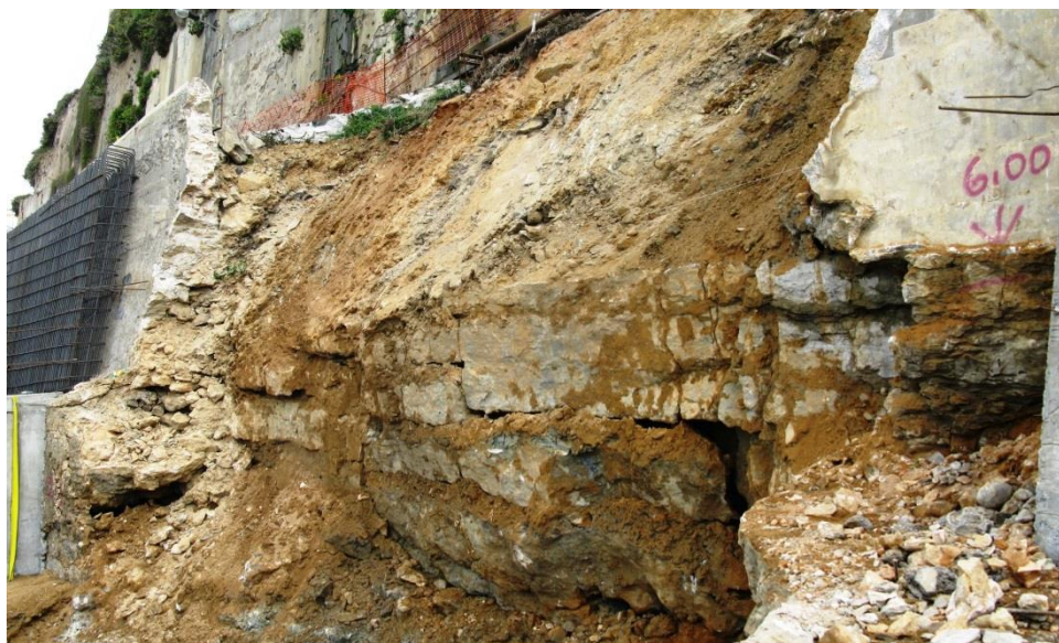
Figura 4.8: Zona rompida após saneamento
