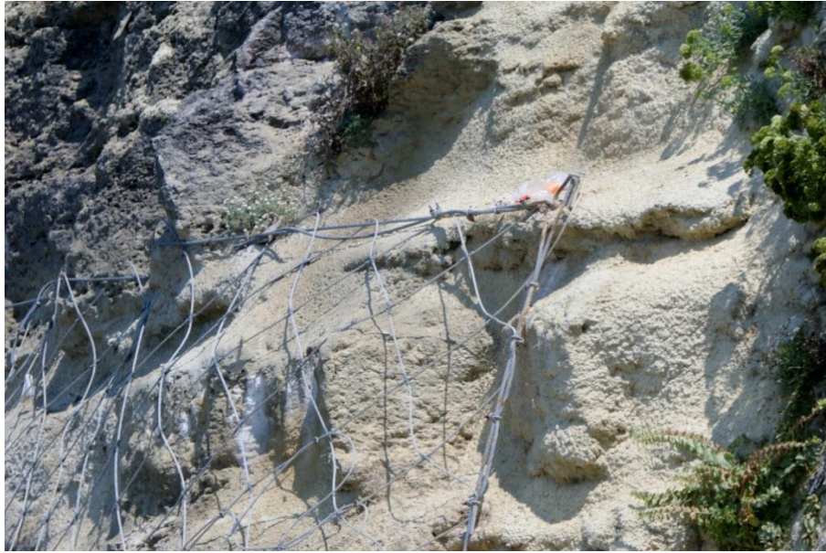
Figura 4.5: Pormenor da pregagem da malha
