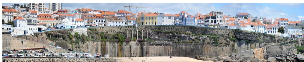
Figura 3.16: Panorama da Praia dos Pescadores após rotura da rampa
