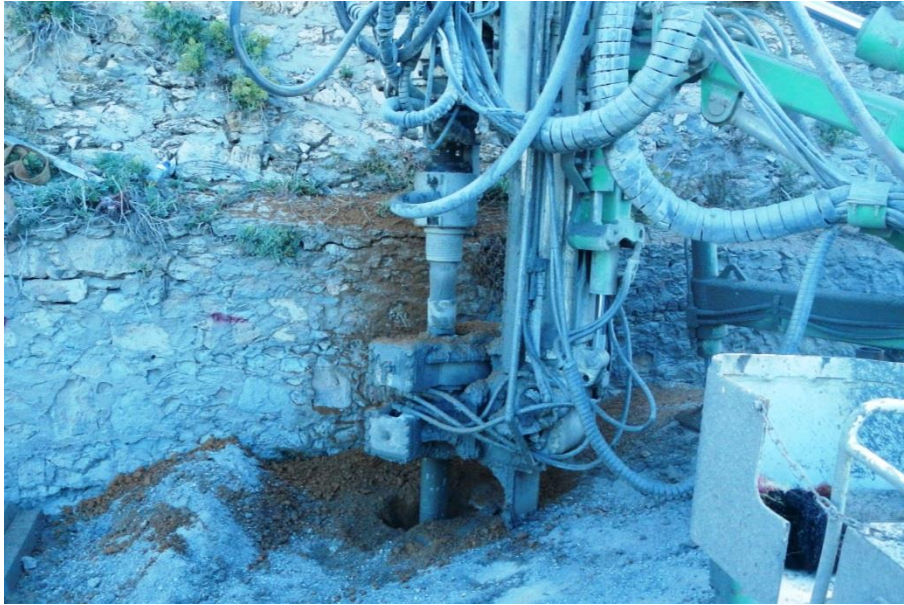
Figura 4.1: Furação destrutiva com roto-percussão para as microestacas
