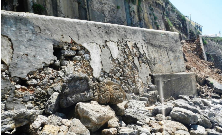
Figura 4.12: Aspecto do muro em alvenaria original, em 2012
