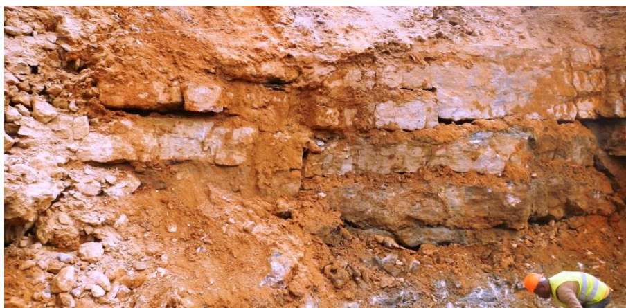
Figura 4.23: Aspecto dos blocos abatidos sob blocos sãos
