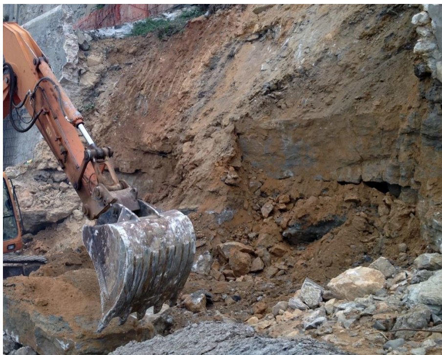
Figura 4.26: Limpeza da zona rompida, com retirada de blocos calcários instáveis.
