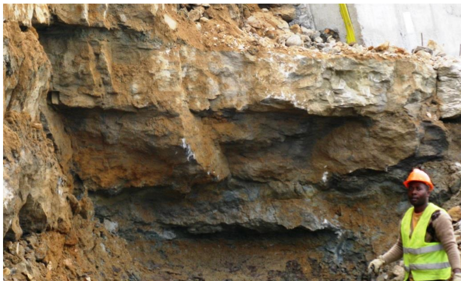
Figura 4.20: Calcários pouco alterados sob o muro no lado Sul da rotura
