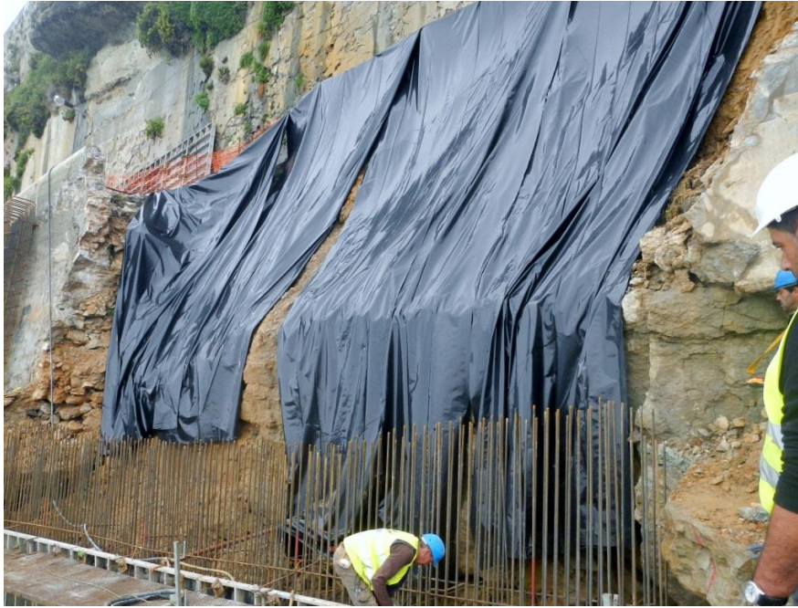
Figura 4.29: Impermeabilização provisória do aterro rompido com cobertura plástica
