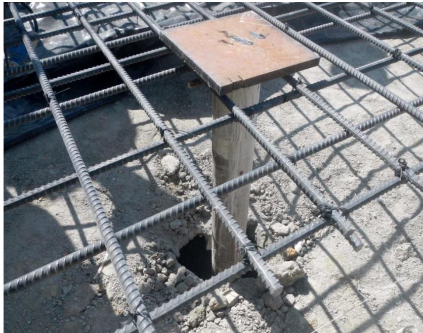
Figura 4.2: Pormenor de uma microstaca para a fundação da grua
