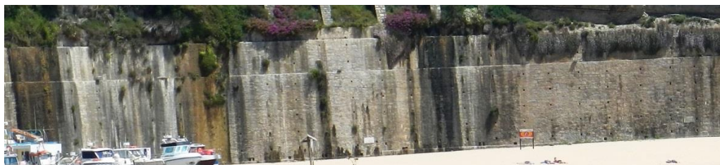
Figura 3.6: Muro executado entre 1924 e 1929, com 15m de altura na área do areal da praia dos Pescadores
