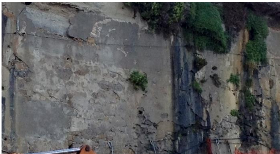
Figura 3.23: Aspecto do muro original sobre a rampa
