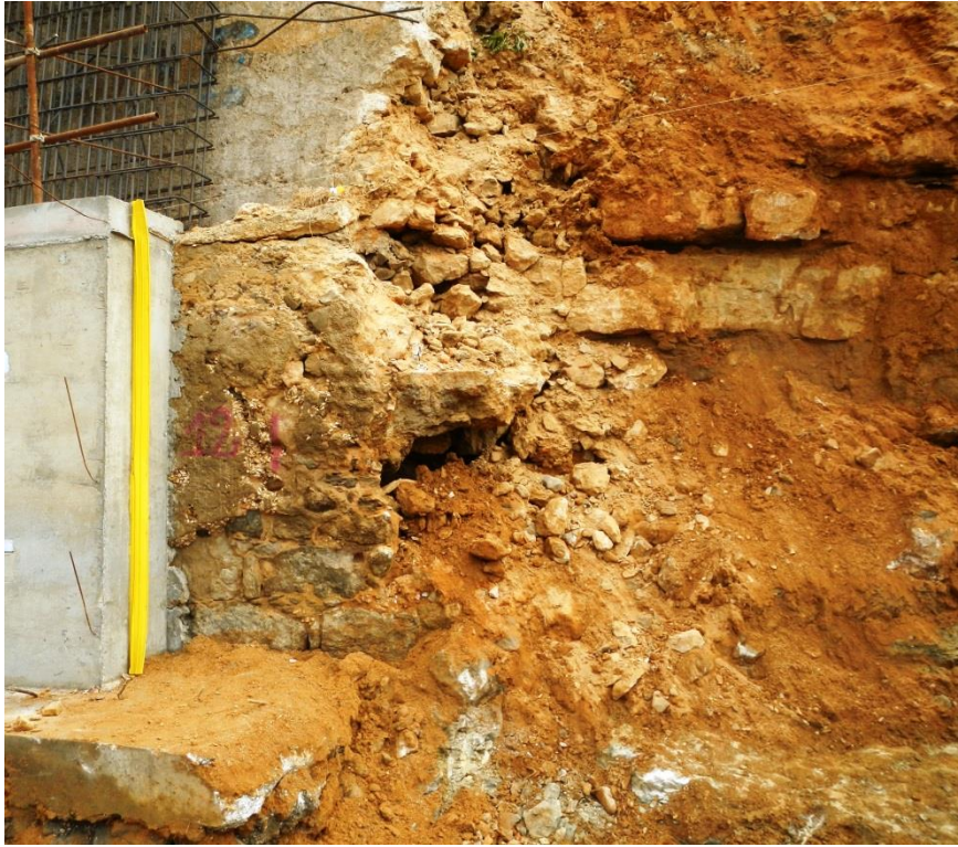
Figura 4.9: Aspecto dos terrenos no tardo do muro de alvenaria após o seu saneamento
