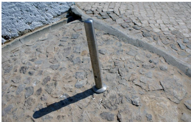
Figura 4.39: Pilarete instalado no topo da rampa Sul
