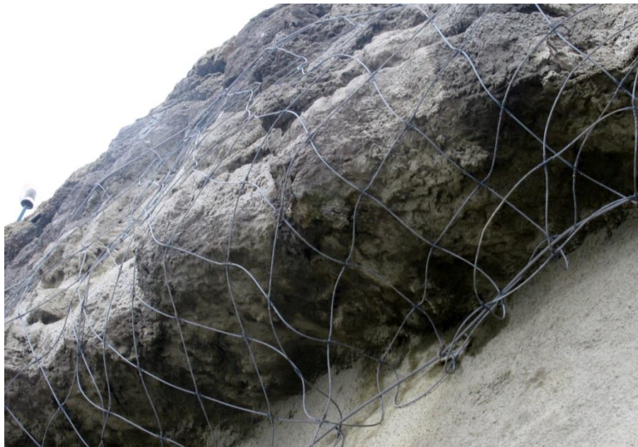
Figura 4.4: Vista da malha metálica pregada
