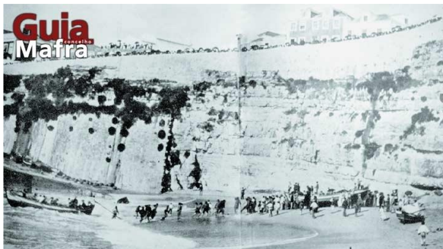
Figura 3.29: Foto de 5 de Outubro de 1910, mostrando o muro de suporte superior na zona Norte e central da praia dos Pescadores, mostra o aspecto geral da falésia da praia dos Pescadores (Camara Municipal de Mafra, 2001)
