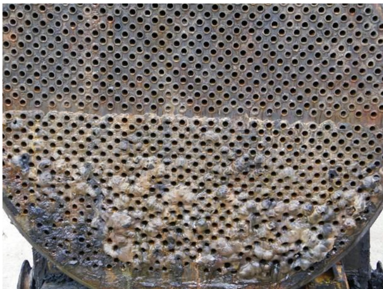
Figura 8 - Interior do permutador de calor CC-E1A3, em Fevereiro de 2011.
