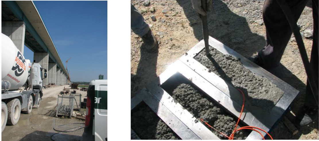
Figura 3.7: Moldagem de provetes com betão de pontes
