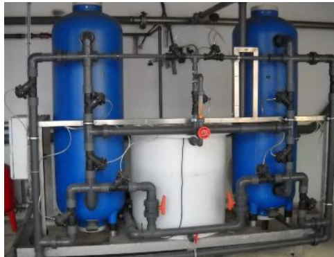
Figura 2.10: Descalcificadores da Fábrica Lever
