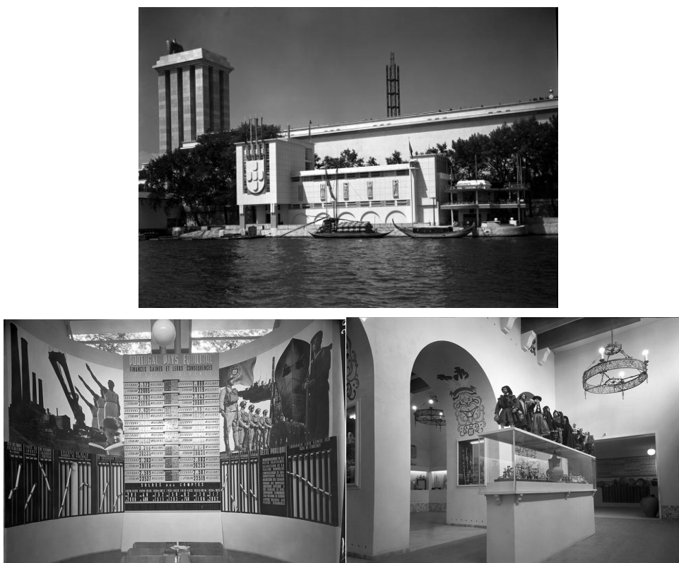
Fig. 53: Pavilhão de Portugal na Exposição Internacional de Paris, 1937. Perspetiva do exterior do edifício, Sala do Estado e Sala de Arte Popular. © Foto Mário Novais, FCG-BA
