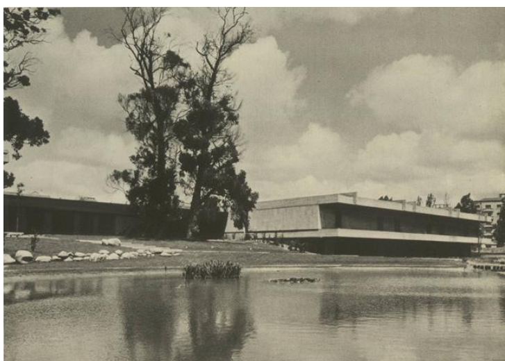
Fig. 101: Pormenor do edifício da Sede e Museu da FCG, após a sua inauguração, 1969 in Colóquio: Revista de artes e letras . Nº 56 (dez. 1969), p. 44
