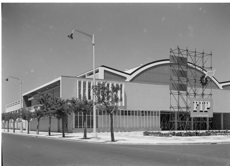
Fig. 69: Edifício da Feira das Indústrias de Lisboa Arquitetos: Keil do Amaral e Alberto Cruz © Foto Mário Novais, FCG-BA
