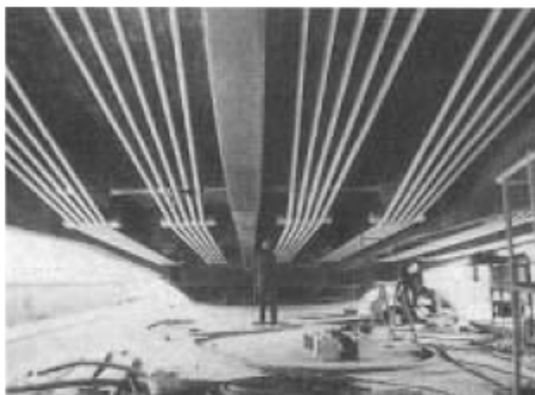
Figura 2.2 – Ponte ferroviária de Aue, projectada por Dischinger (VSL International 1992).
