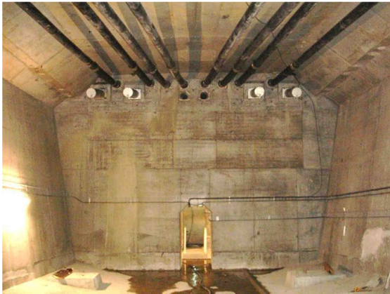
Figura – 3.73 – Ancoragens sobre o pilar.
