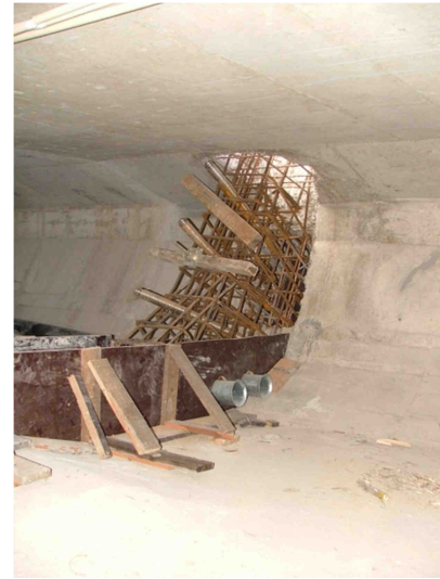
Figura 3.53 – Armadura do septo.
