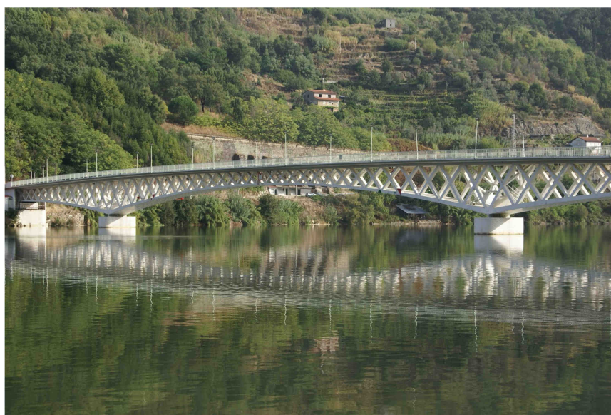
Figura 3.93 – Ponte de Mosteirô.
