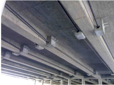
Figura 2.9 – Viaduto em Bicesse, Portugal.
