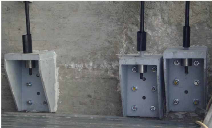
Figura 4.23 – Ancoragem dos cabos.
