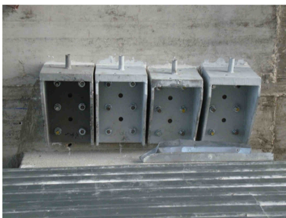
Figura 4.18 – Ancoragens passivas.
