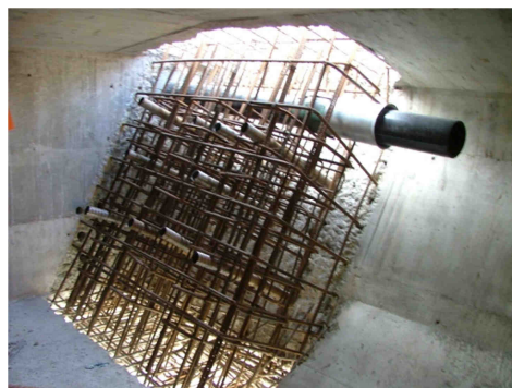
Figura 3.45 – Armaduras no maciço.
