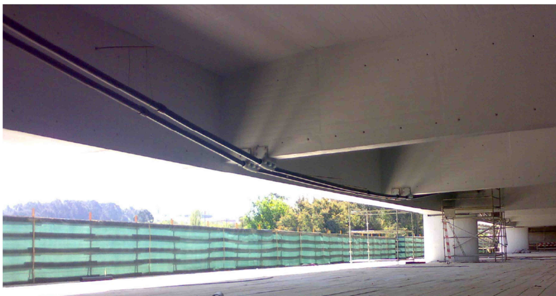
Figura 3.90 – Aspecto final do reforço.
