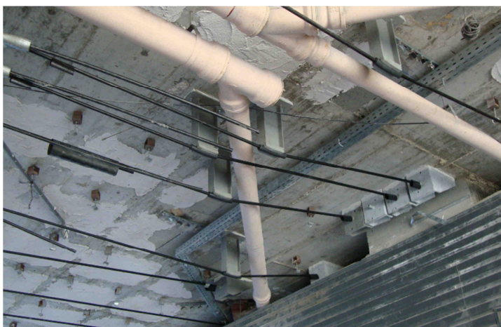
Figura 4.27 – Traçado dos cabos entre obstáculos.
