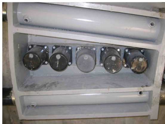
Figura 3.81 – Aparelho de ancoragem interior.
