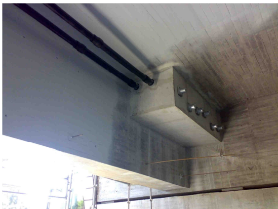
Figura 3.86 – Maciço junto ao encontro.
