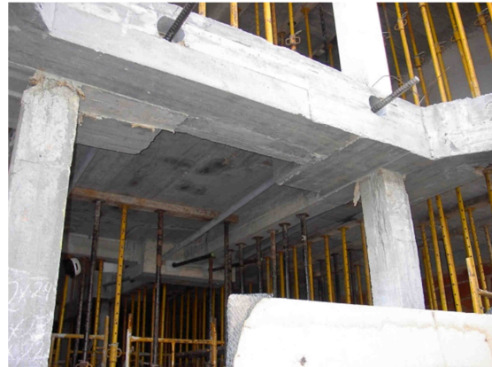
Figura 3.6 – Colocação de barras.
