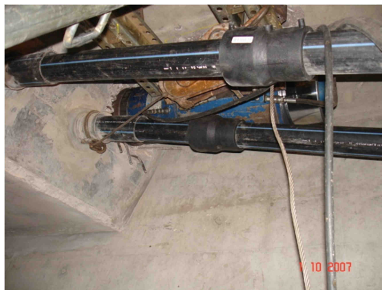
Figura 3.77 – União dos cabos e macaco.
