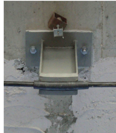
Figura 4.24 – Cabo aplicado na sela de desvio.
