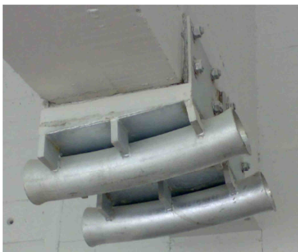
Figura 3.88 – Vista lateral da sela de desvio.
