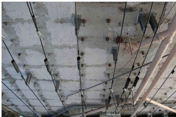
Figura 4.26 – Traçado dos cabos em obra.
