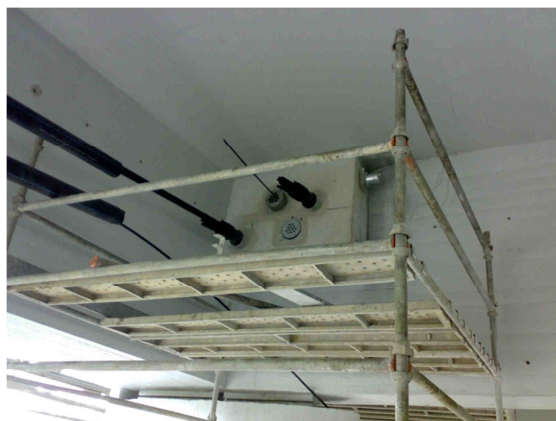
Figura 3.87 – Maciço sobre o pilar central.
