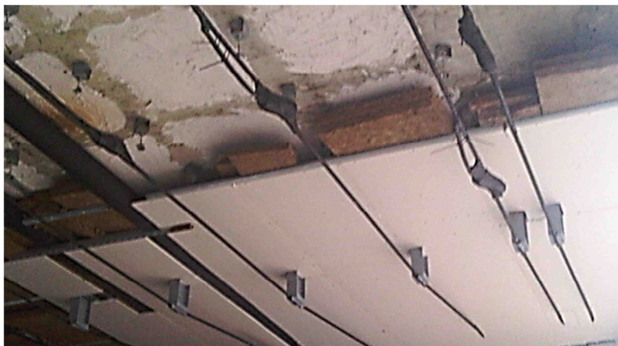
Figura 4.38 - Colocação do tecto falso.
