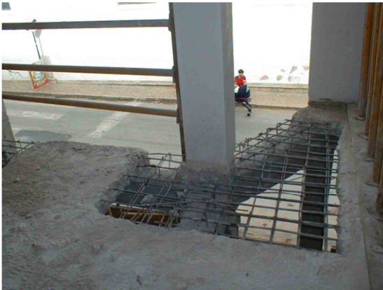
Figura 3.5 – Demolição de laje.
