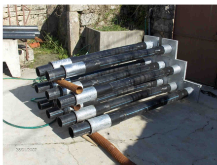
Figura 3.62 – Tubos de ancoragem pré-fabricados.
