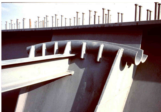
Figura 2.52 – Desviador em tubo metálico.
