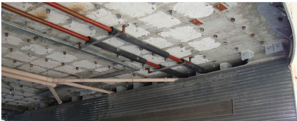
Figura 4.20 – Vista das ancoragens passivas.
