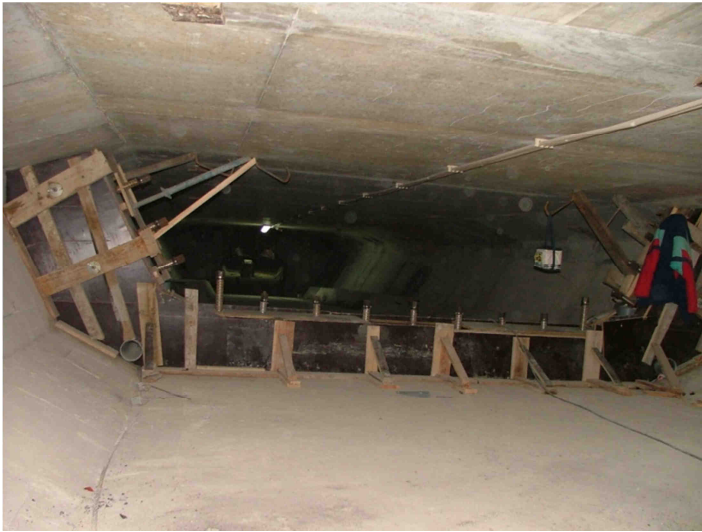
Figura 3.52 – Cofragem do septo.
