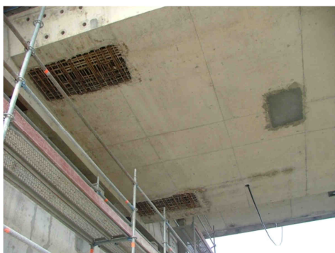
Figura 3.44 – Aberturas na laje.
