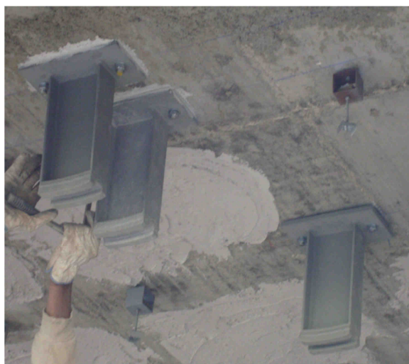
Figura 4.22 – Selas de desvio aplicadas.
