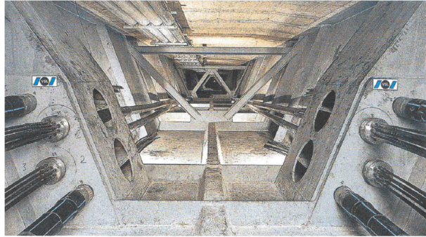
Figura 2.10 – Viaduto Bois de Rosset, Suíça.
