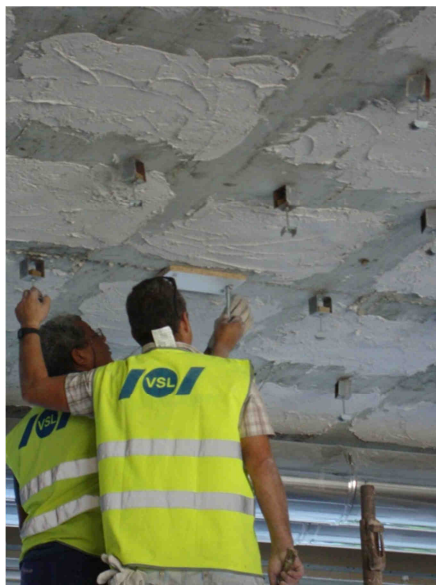
Figura 4.17 – Colocação dos varões roscados.
