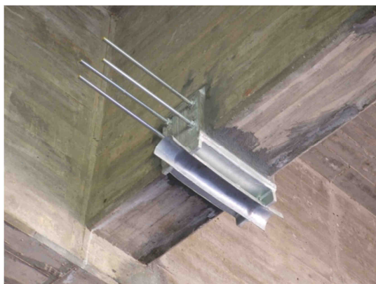
Figura 3.33 – Montagem de sela de desvio.
