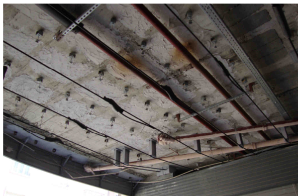
Figura 4.34 – Ancoragens activas protegidas.
