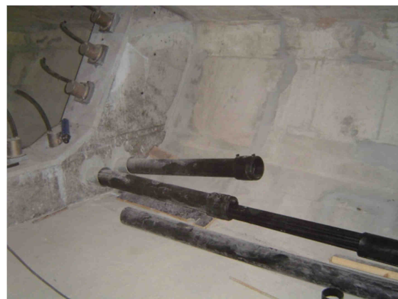
Figura 3.55 – Colocação dos cabos.
