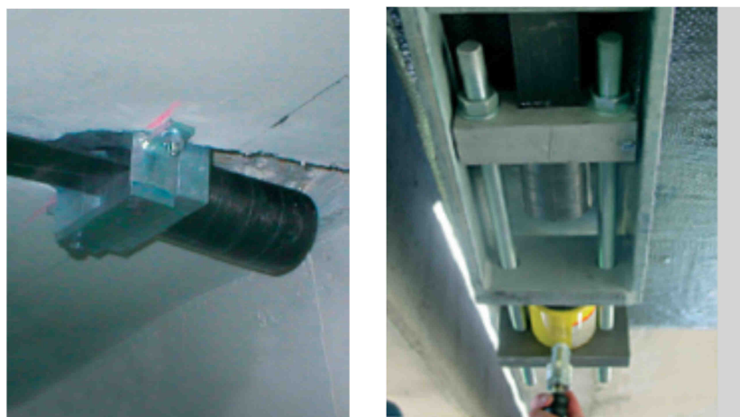
Figura 2.77 – Ancoragem passiva e activa do tipo StressHead (SIKA).
