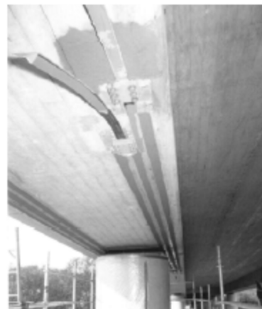
Figura 2.16 – Ancoragens e laminado de CFRP sobre o pilar. (Andra e Maier 2000).
