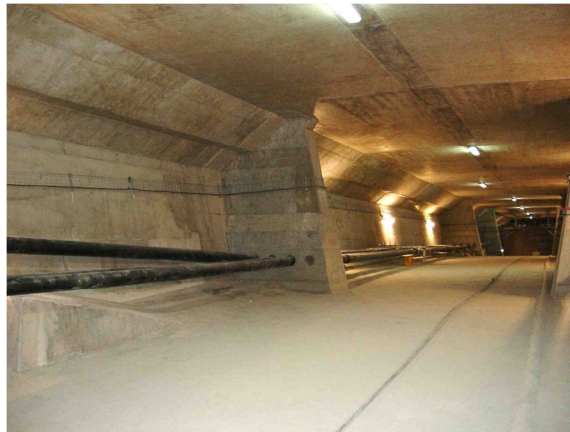
Figura 3.75 – Trajectória dos cabos a meio vão.
