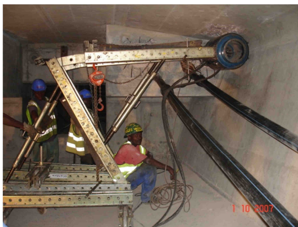
Figura 3.78 – Auxiliar de levantamento do macaco hidráulico.
