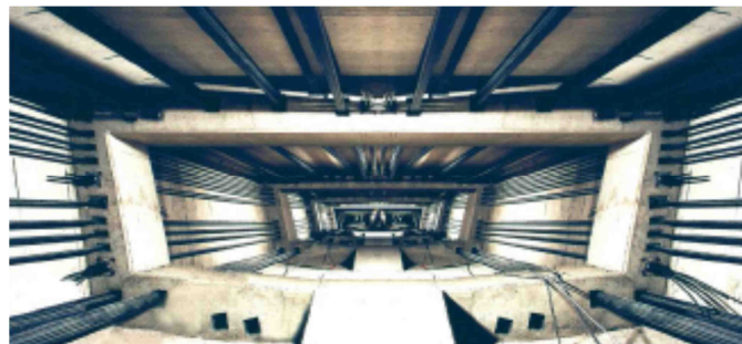
Figura 2.6 – Viaduto de Rumbeck na fase de construção (Weiher e Zilch 2008).
