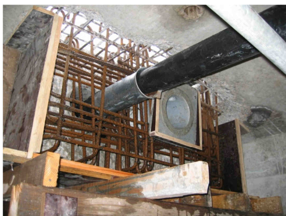
Figura 3.48 – Armadura do bloco.
