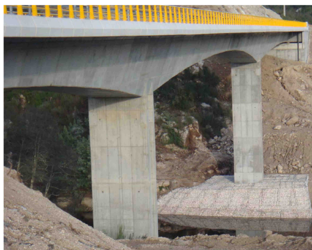
Figura 3.91 – Ponte sobre o Rio Dão.
