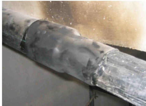
Figura 2.51 – União Termo-Retráctil.
