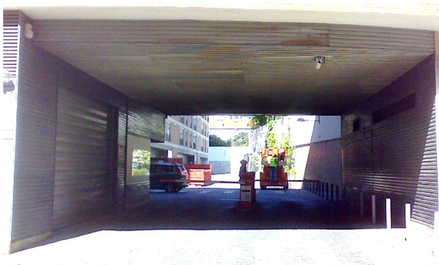
Figura 4.39 – Aspecto final da obra
