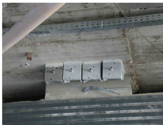
Figura 4.19 – Vista das ancoragens passivas.
