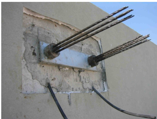
Figura 3.40 – Sistema de ancoragem.
