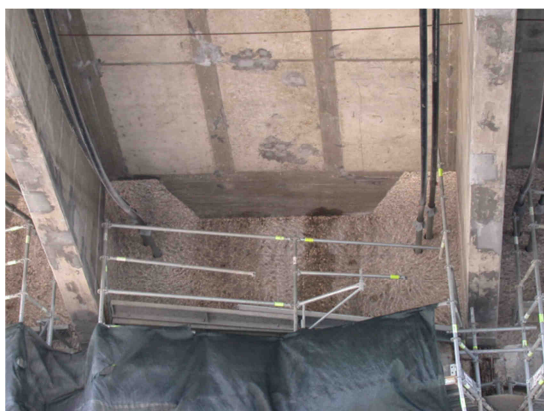
Figura 3.15 – Saneamento de betão.
