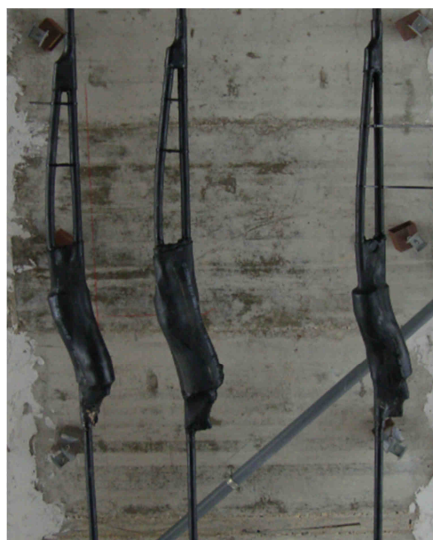
Figura 4.30 – Aplicação de calor na manga termo-retráctil. Figura 4.31 – Selagem das ancoragens activas.
