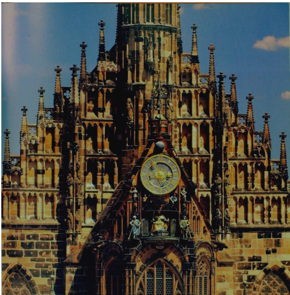
Figura 26 – Frauenkirche, Nuremberga, início da construção em 1350.
