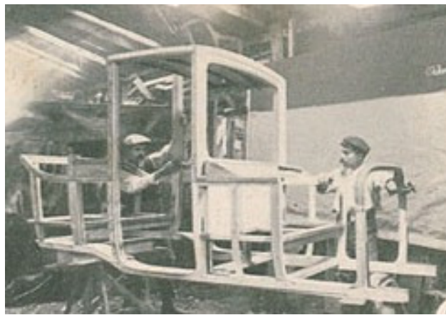
Figura 10.3 – Produção artesanal de uma carroçaria, nas instalações da empresa Ferreira & Viegas, Lda Fonte: Ilustração Portuguesa (Lisboa), 311 (1912), 189.
