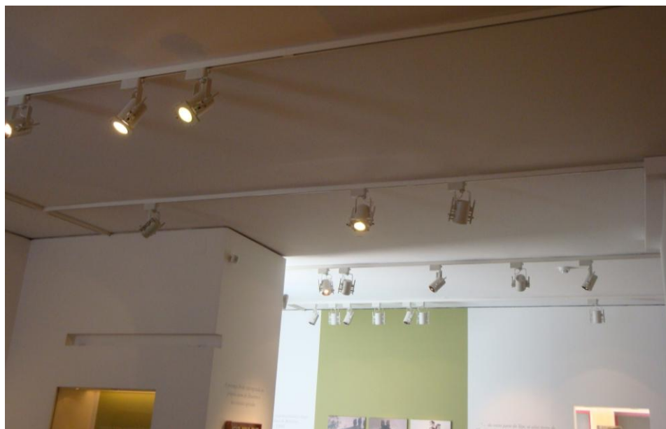
Figura 4.14 – Pormenor das calhas com os projectores de iluminação da exposição de longa duração do Museu.
