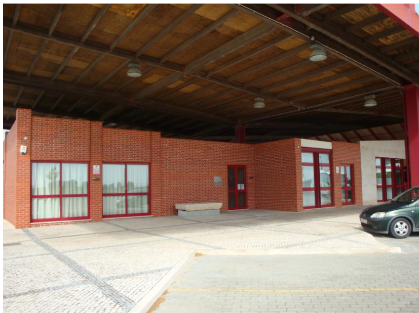
Figura 4.3 – Vista geral do exterior do edifício do Museu.
