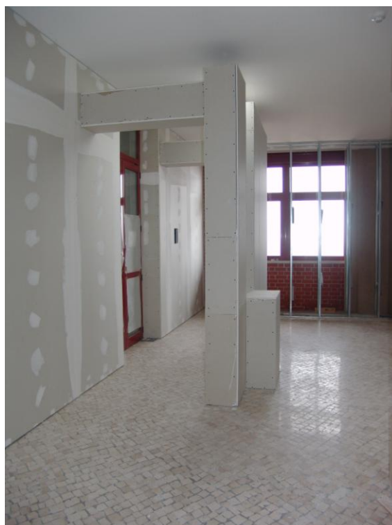
Figura 4.4 – Construção de paredes falsas para controlo da entrada de luz natural na sala de exposição de longa duração do Museu.
