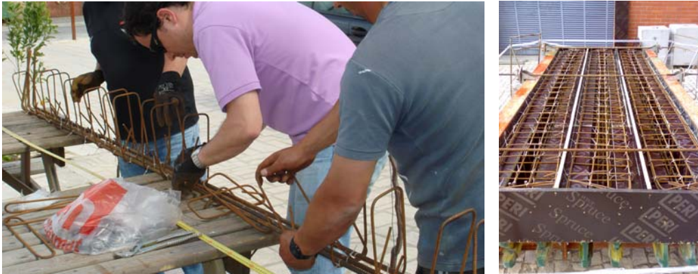
Figura 6.8: Preparação da armadura e cofragem utilizadas nas vigas de secção transversal em T.
