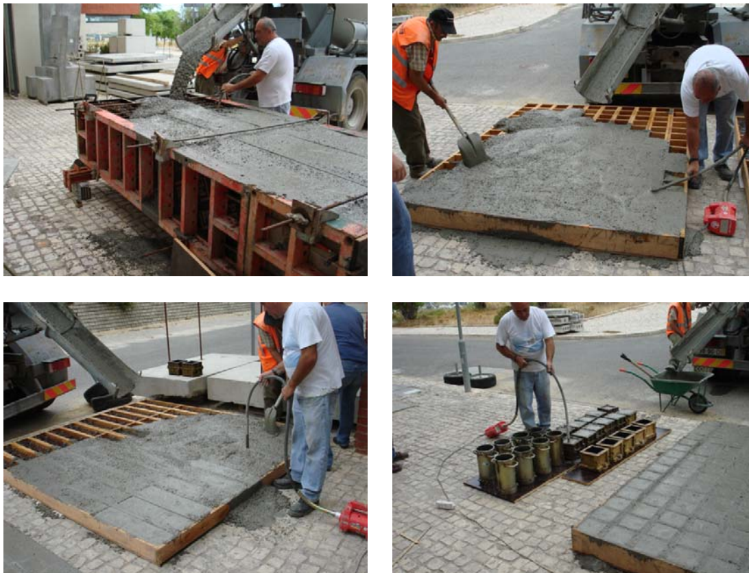
Figura 3.9: Betonagem das peças de betão armado.
