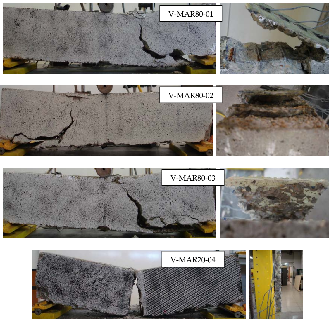
Figura C.18: Modos de ruptura das vigas submetidas a ciclos de marés - 3000 horas.
