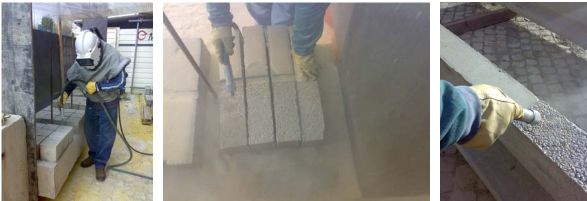
Figura 3.4: Preparação das superfícies de betão a jacto de areia (da esquerda para a direita) dos provetes de corte, das vigas de secção rectangular e das vigas com secção em T.
