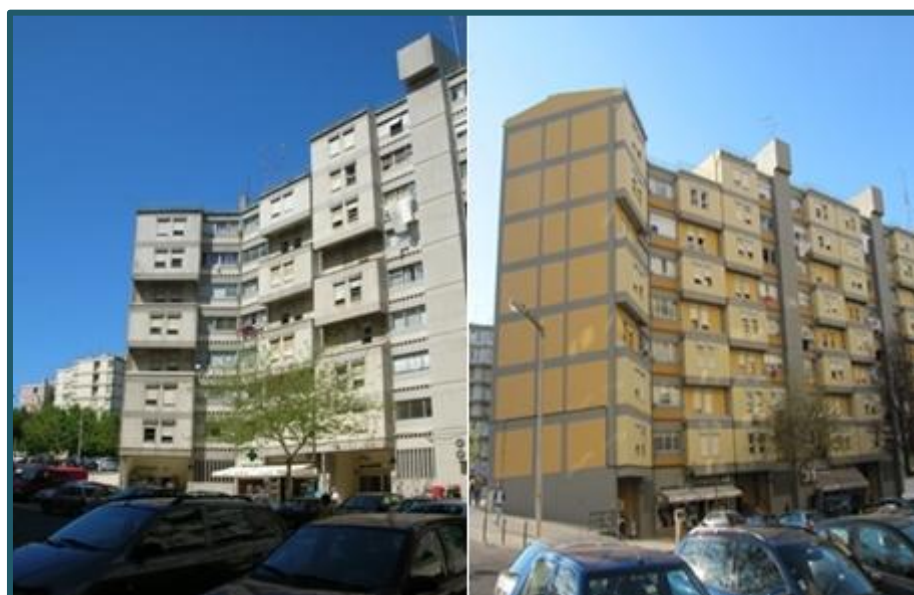
Figura 4.6. Reabilitação dos edifícios do bairro das Amendoiras, resultante da realização de um estudo de cor para o bairro (Fonte: Viver Marvila, 2011)
