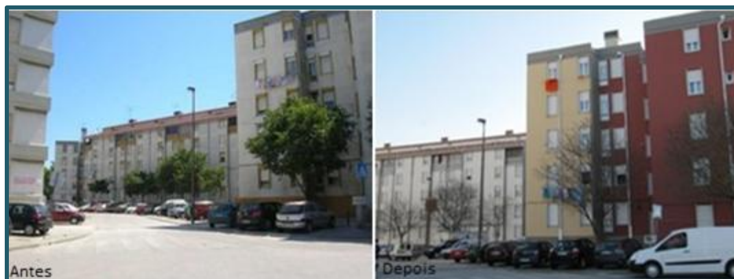
Figura 4.5. Reabilitação de lotes e do espaço público no bairro das Amendoiras (Fonte: Viver Marvila, 2011)
