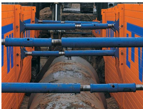
Figura AVI.1 – Utilização de entivação na execução de colector (Concretex, 2011).
