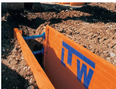
Figura AVI.2 – Utilização de entivação para estabilização de vala (Concretex, 2011a).
