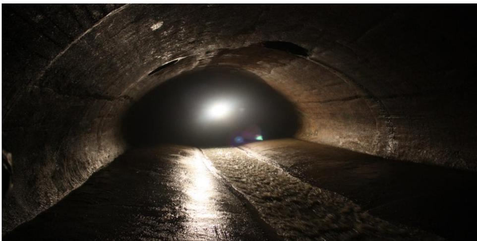
Figura 44 – Caneiro de Alcântara, escoamento de águas residuais em tempo seco.
