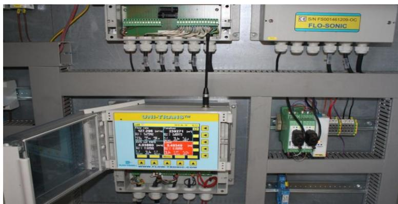
Figura 36 – Quadro electrónico do medidor de caudal FLODAR
