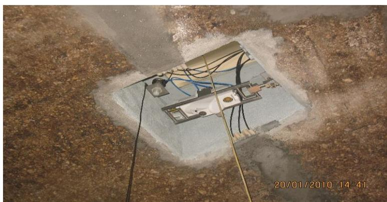
Figura 37 – Medidor de caudal FLODAR, visto no interior do Caneiro de Alcântara
