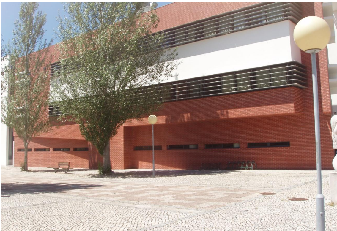
Figura 5.3: Fachada do edifício após a intervenção da empresa de construção civil
