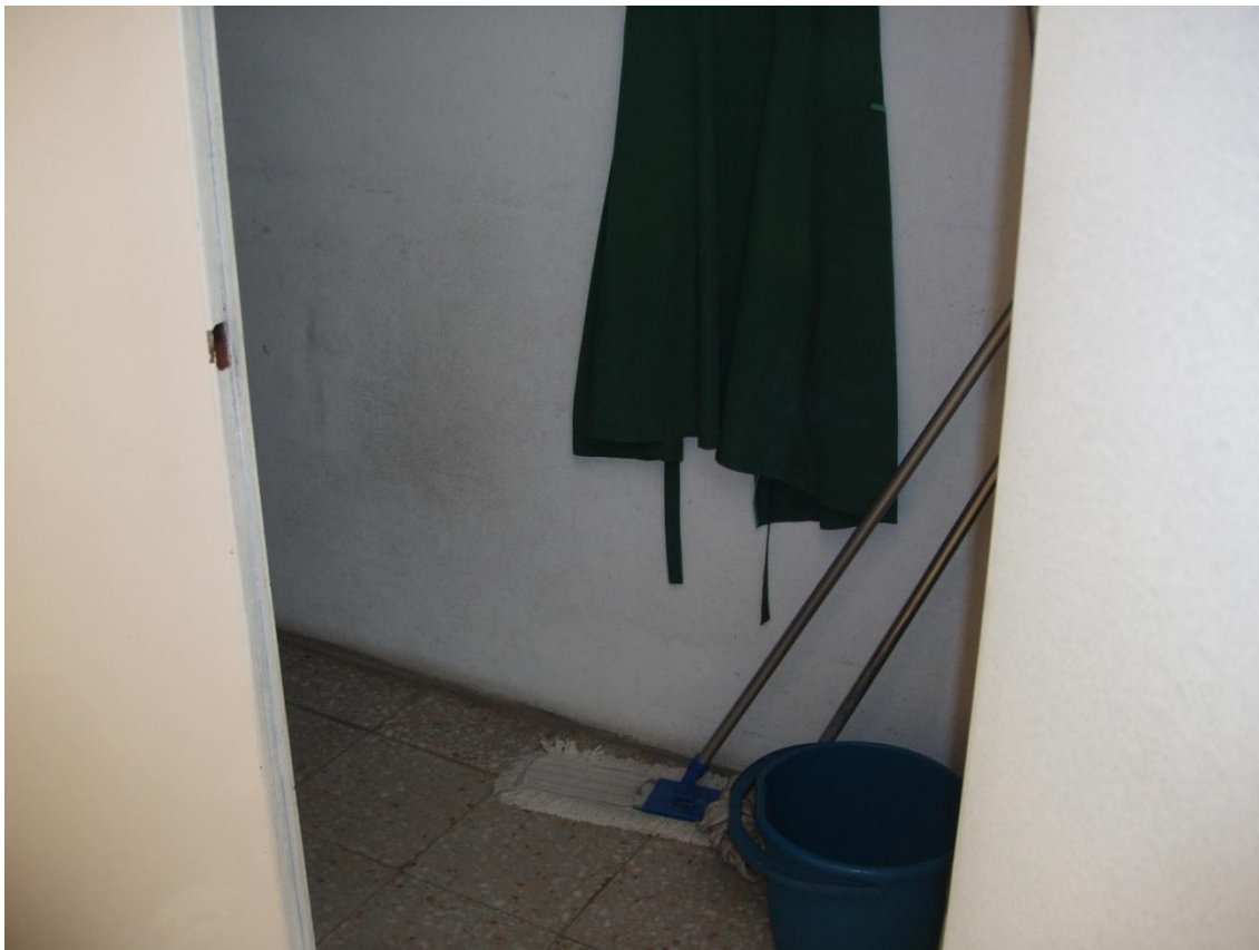
Figura 5.4: Compartimento para a arrumação de produtos e equipamento
