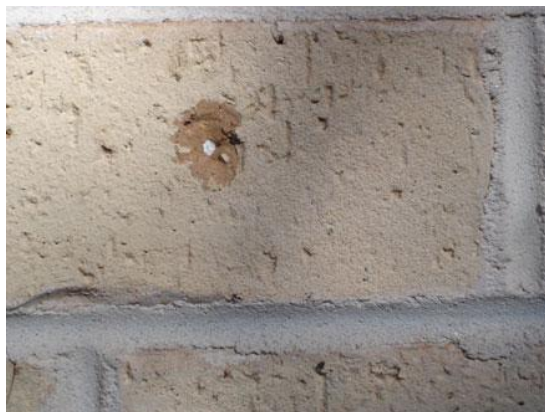
Figura 4.10 – Picamento em material cerâmico. http://www.australbricks.com/02-brick-properties-and-bricklaying-practices
