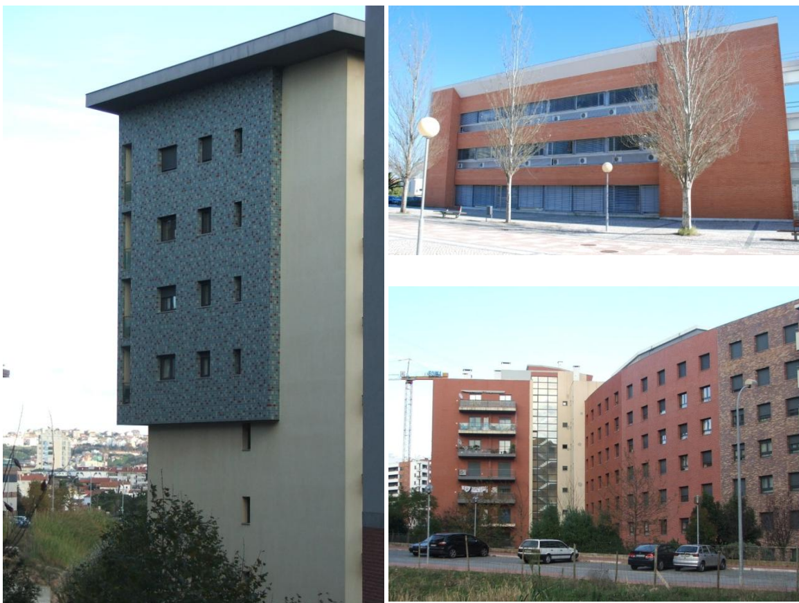
Figura 3.31 – Exemplos de aplicação de ladrilhos cerâmicos em edifícios recentes.
