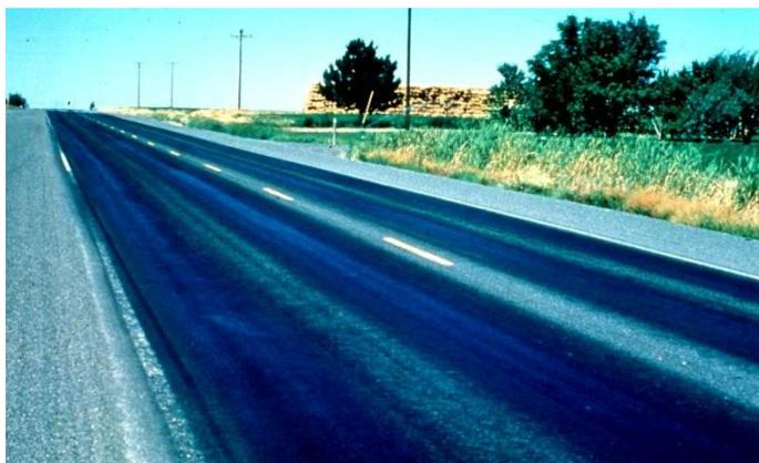
Figura 2.23 - Aspecto dum pavimento com exsudação (Pavement Interactive, 2008)
