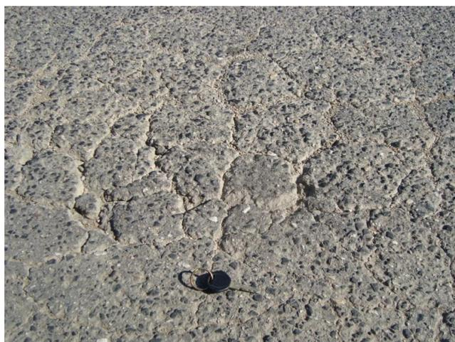
Figura 2.20 - Fendilhamento tipo "pele de crocodilo"
