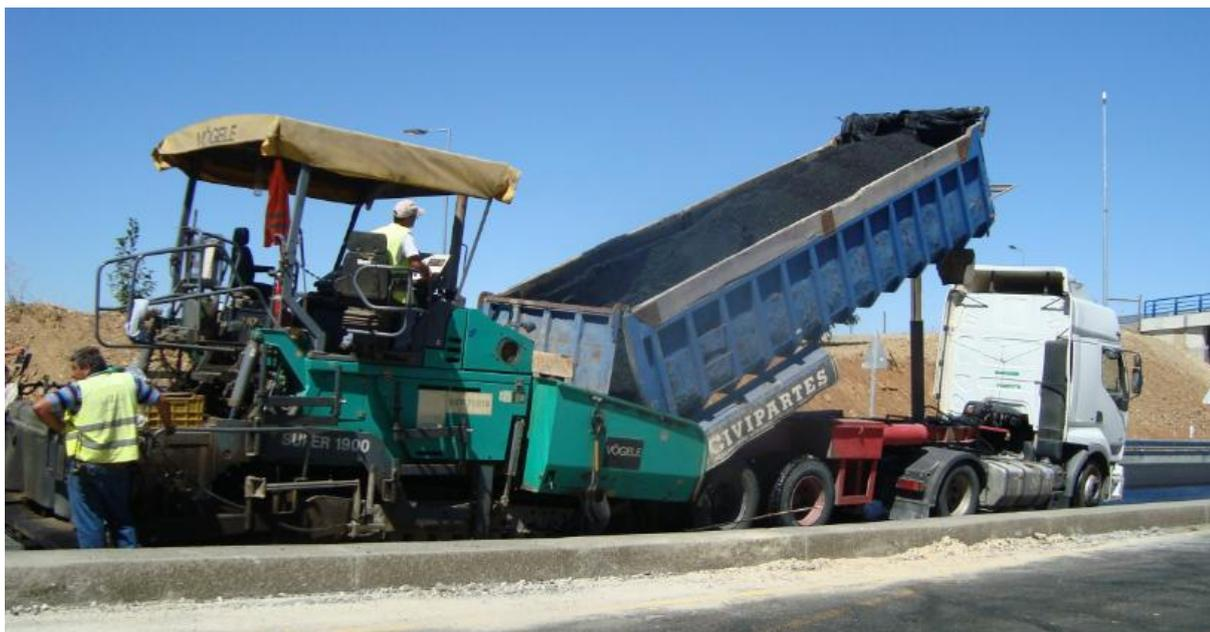
Figura 2.16 - Colocação da mistura betuminosa na pavimentadora
