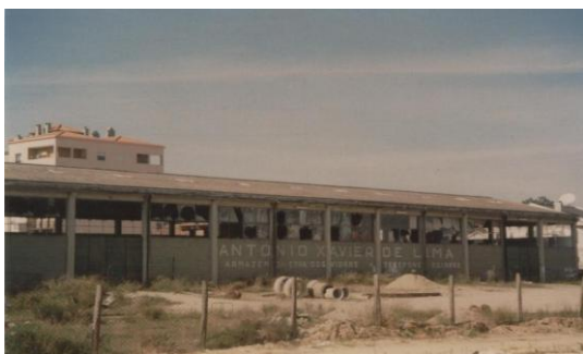
Figura 61 – Armazém abandonado no lote onde está actualmente o Lidl (2000). Fonte: Vítor Antunes
