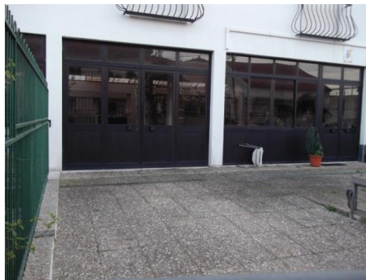
Figura 72 – Armazém no piso térreo, integrado na fachada habitacional, na Rua Duarte Pacheco (2011). Fonte: Autor
