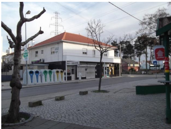
Figura 65 – Habitação convertida em espaço de serviços na Rua da Fraternidade (2011). Fonte: Autor
