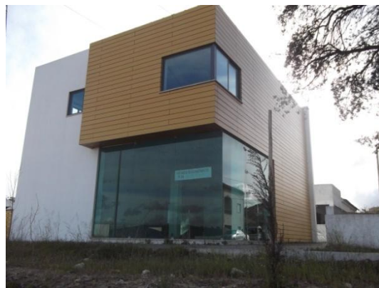
Figura 70 – Mau exemplo de edifício construído exclusivamente para serviços, na Rua da Harmonia (2011).
