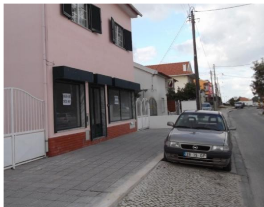
Figura 60 – Má interligação entre os espaços pedonais e o estacionamento na Avenida da Liberdade (2011).
