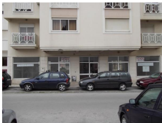
Figura 74 – Lojas para venda no piso inferior de um edifício plurifamiliar na Rua Damião de Góis (2011).
