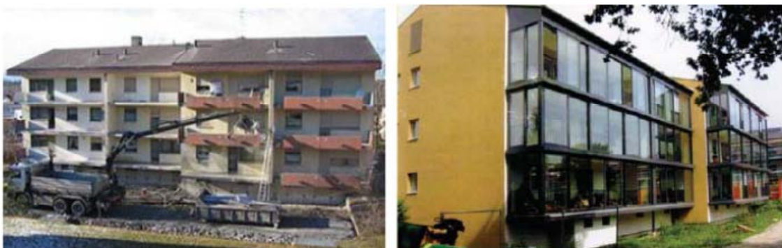
Figura 2.5 - Aspecto da fachada antes e depois da aplicação de solário [17]
