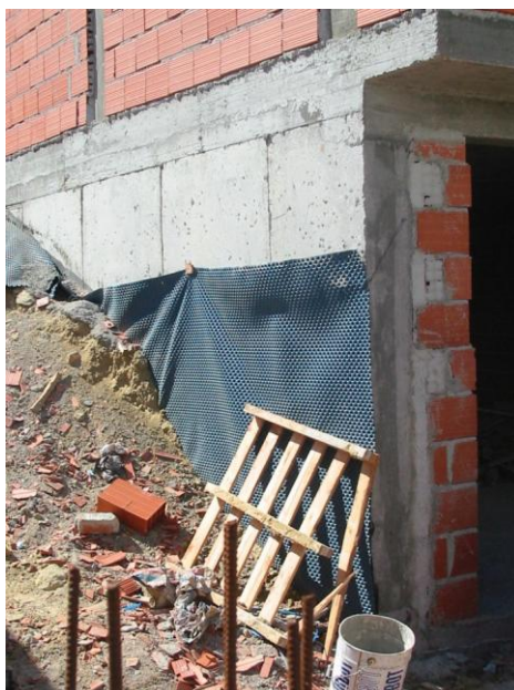
Figura 5.j - Vista pelo exterior da cave
