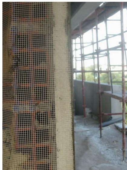
Figura 3.k - Elementos constituintes do sistema "ETICS"
