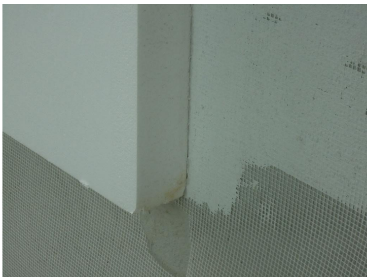
Figura 4.e - Sistema construtivo "ETICS"
