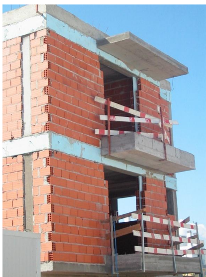
Figura 3.j - Vista pelo exterior da habitação
