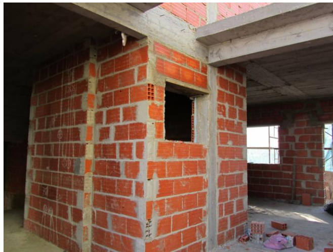
Figura 5.c - Vista sobre o interior da cave
