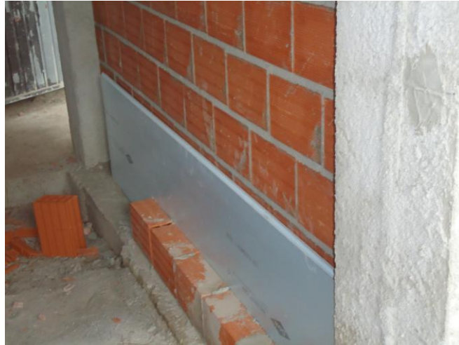
Figura 2.f - Vista pelo interior da parede da envolvente exterior
