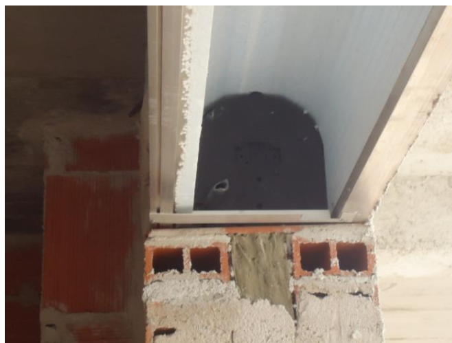
Figura 2.h - Vista sobre uma zona de ligação de parede exterior com caixa - de - estore
