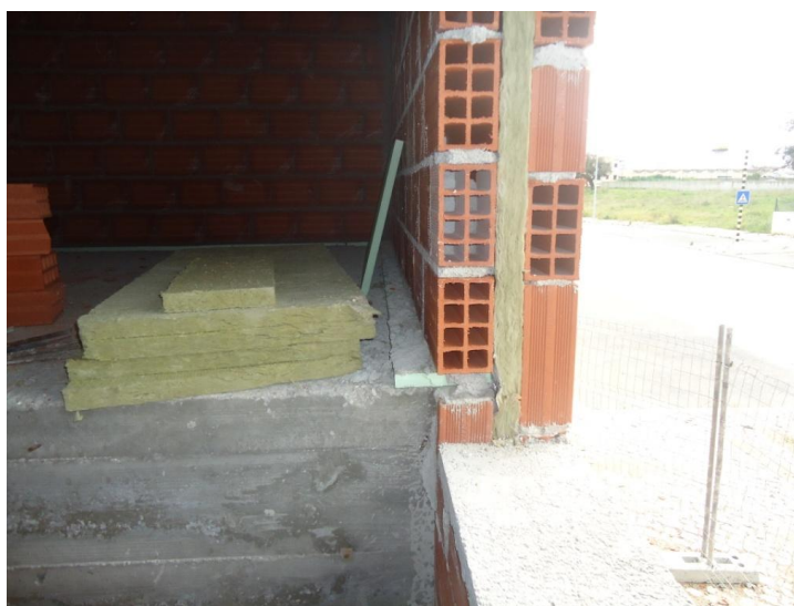
Figura 3.g - Vista sobre a parede de pano duplo
