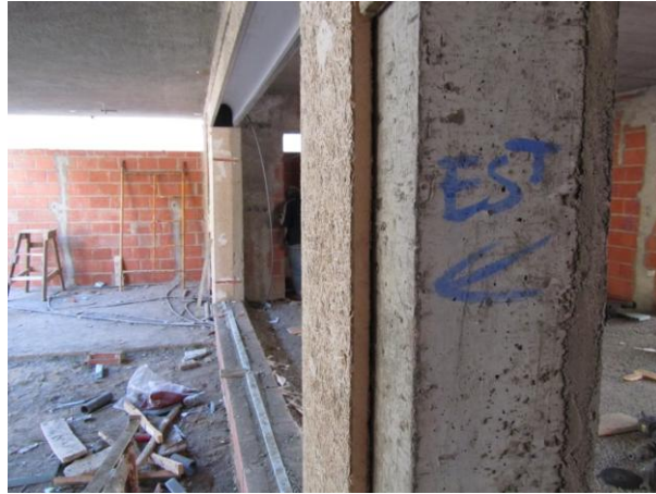
Figura 4.b - Vista pelo exterior dos pilares e da caixa de estore
