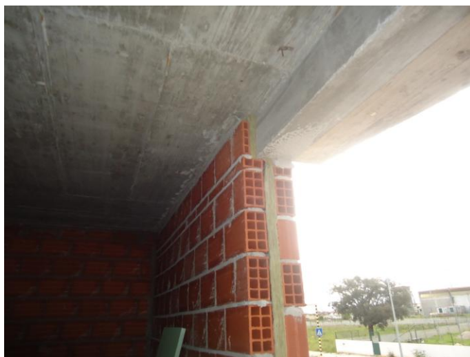
Figura 2.g - Vista pelo interior de uma zona de ligação de parede exterior com laje de piso intermédio
