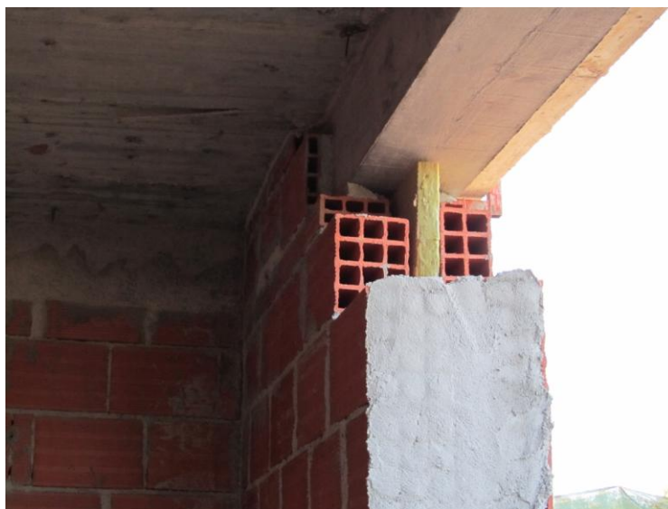
Figura 2.d - Vista pelo interior sobre uma zona de ligação de parede exterior com laje de piso intermédio
