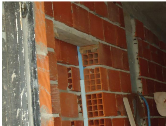
Figura 3.f - Vista pelo interior da parede dupla
