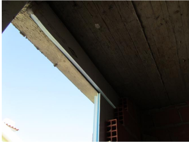
Figura 4.c - Vista sobre uma zona de ligação de parede exterior com laje de piso intermédio
