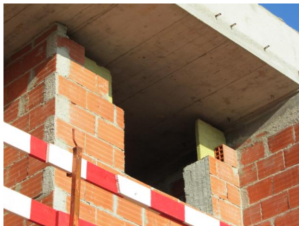
Figura 6.d - Vista pelo exterior de uma zona de ligação de parede exterior com cobertura
