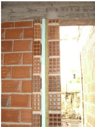
Figura 2.i - Vista sobre a parede exterior
