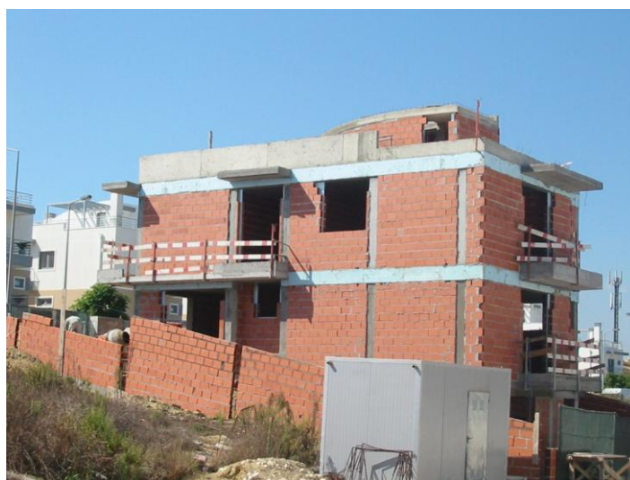
Figura 1.j - Perspectiva geral da obra
