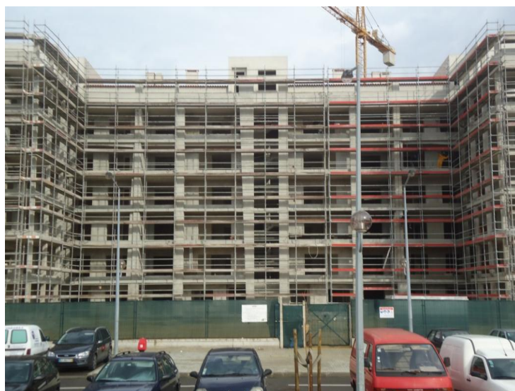
Figura 1.e - Perspectiva global da obra
