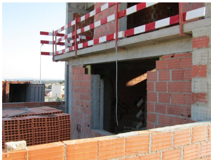
Figura 3.d - Vista pelo exterior sobre uma zona de ligação de parede exterior com laje de piso intermédio
