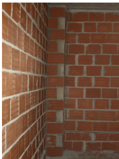
Figura 8.i - Vista sobre uma zona de ligação entre duas paredes verticais com o pilar saliente em relação às paredes
