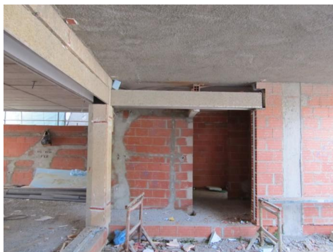
Figura 3.b - Vista pelo exterior do terraço
