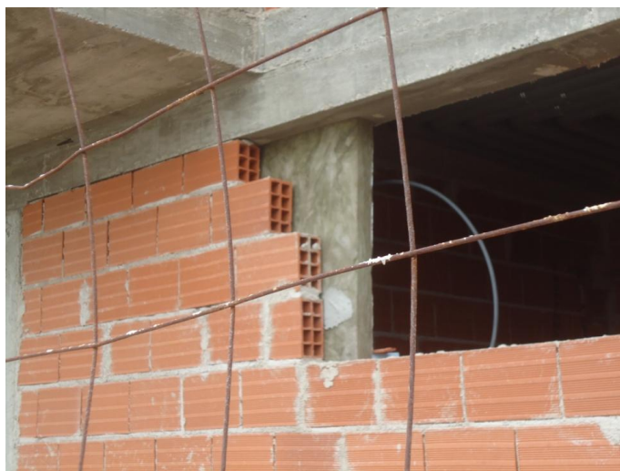
Figura 3.h - Vista pelo exterior de uma zona de ligação de parede exterior com laje de piso intermédio
