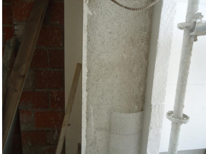
Figura 2.e - Vista sobre a parede exterior
