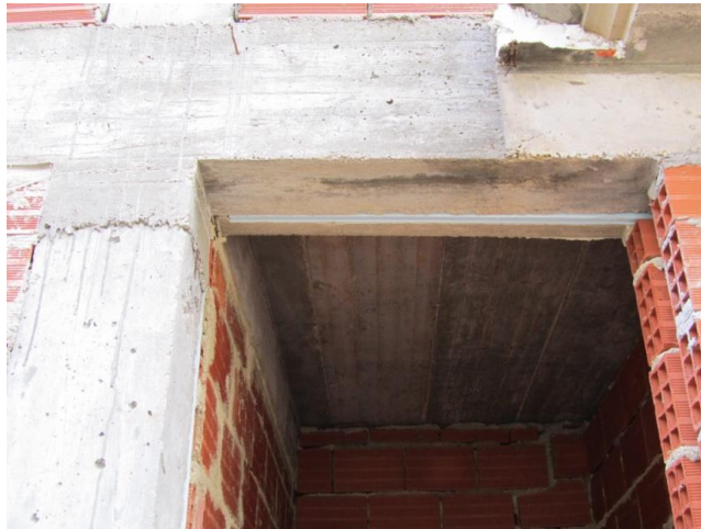
Figura 4.a - Vista pelo exterior da viga e do pilar
