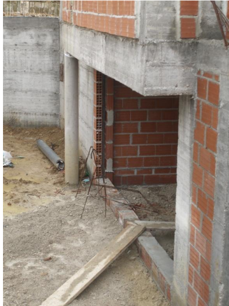
Figura 4.i - Vista pelo exterior da cave
