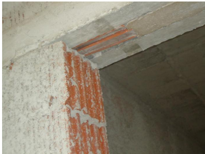
Figura 3.e - Pano de alvenaria de tijolo térmico
