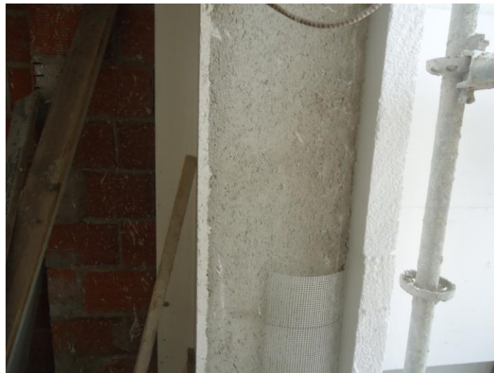
Figura 3.3 - Solução construtiva "ETICS"
