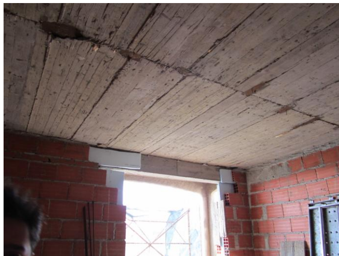
Figura 6.c - Vista pelo interior sobre uma situação de ligação de parede exterior com laje de piso intermédio
