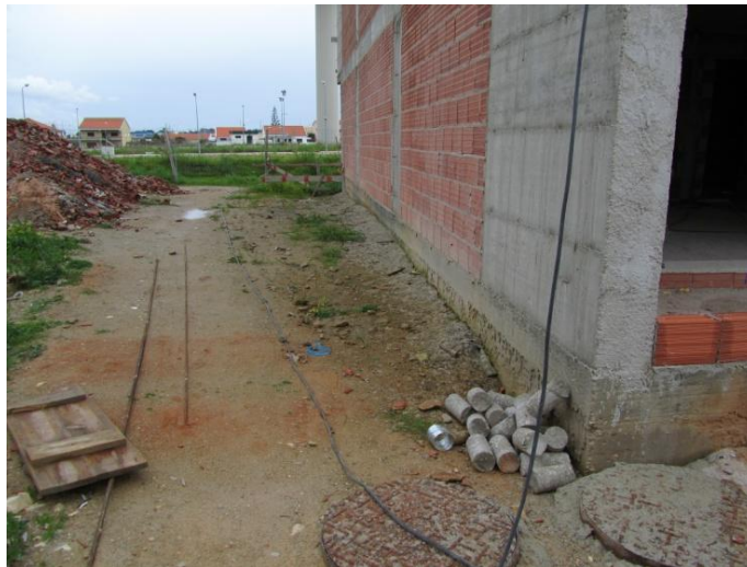
Figura 5.h - Vista pelo exterior do edifício
