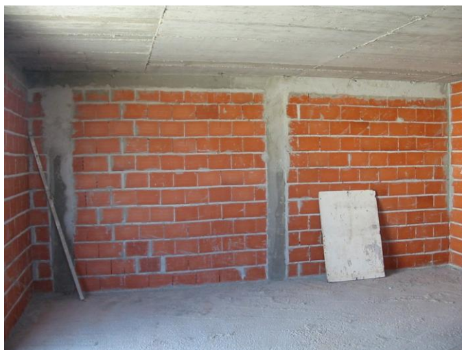
Figura 4.j - Vista pelo interior da cave
