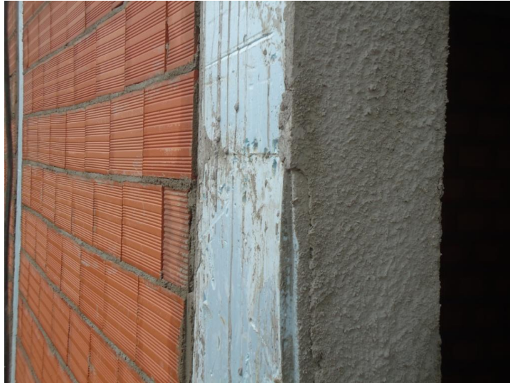
Figura 4.f - Vista sobre o pilar inserido no mesmo alinhamento da parede exterior
