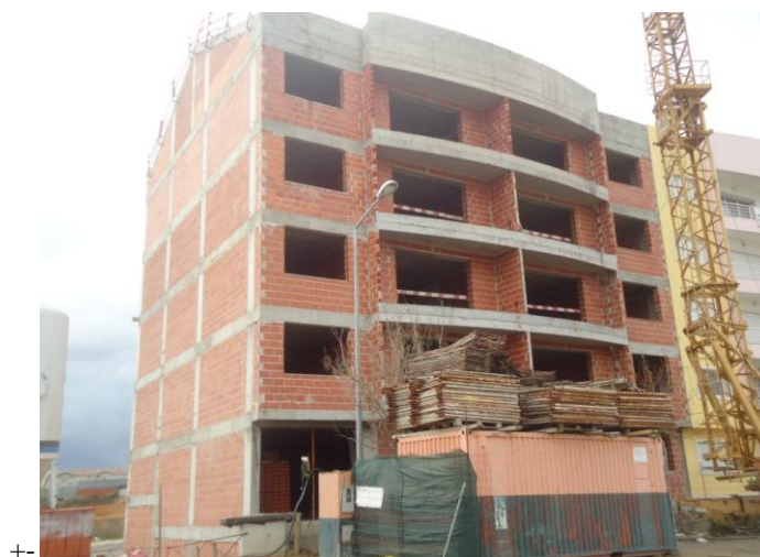
Figura 1.g - Perspectiva global do edifício
