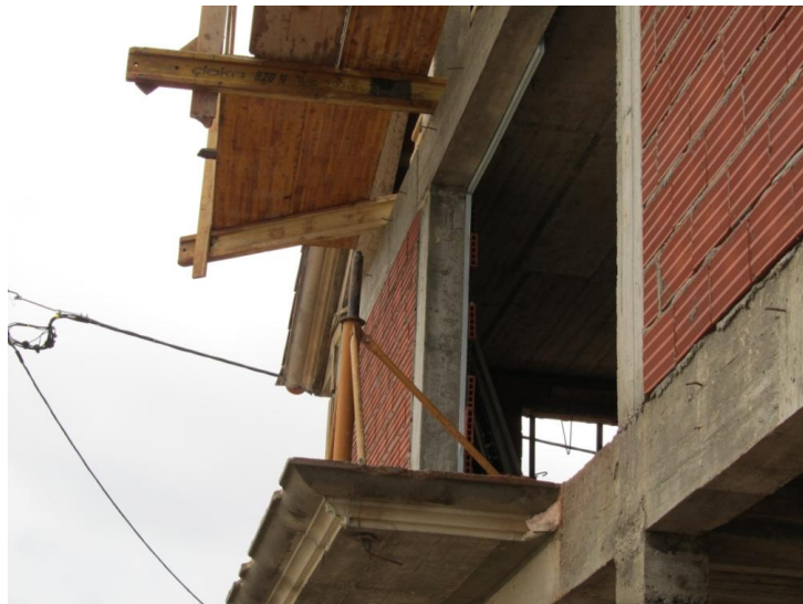
Figura 6.a - Vista pelo exterior da habitação
