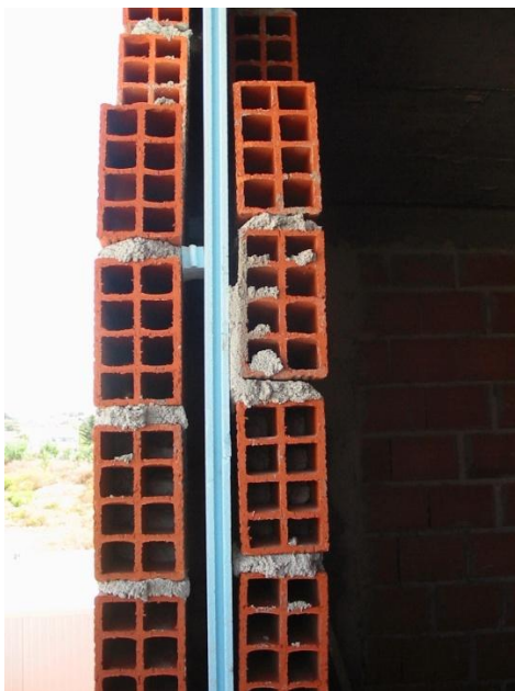
Figura 2.j - Vista sobre a parede da envolvente em contacto com o exterior
