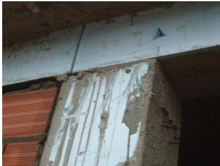
Figura 5.f - Vista sobre uma situação de ligação de parede exterior com laje de piso intermédio
