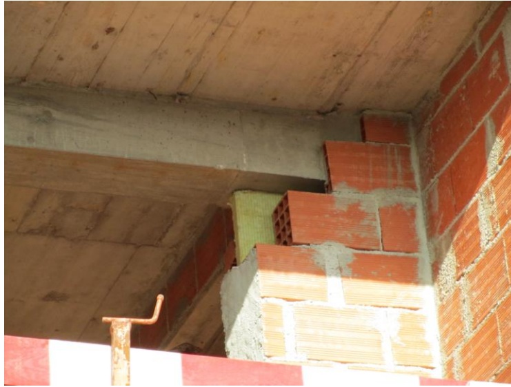
Figura 7.d - Vista pelo exterior sobre vão para caixa -de -estore
