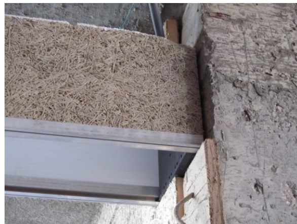
Figura 5.b - Vista sobre a caixa -de - estore
