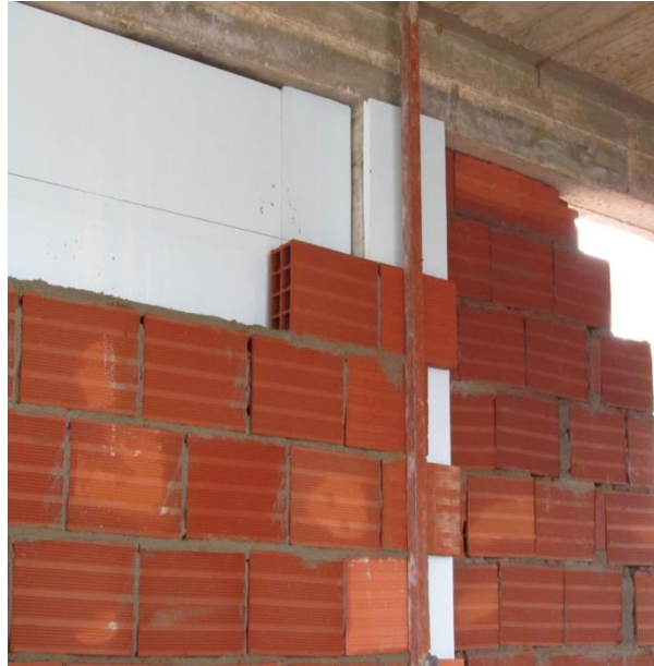
Figura 5.a - Vista pelo interior sobre o pilar inserido no mesmo alinhamento da parede exterior
