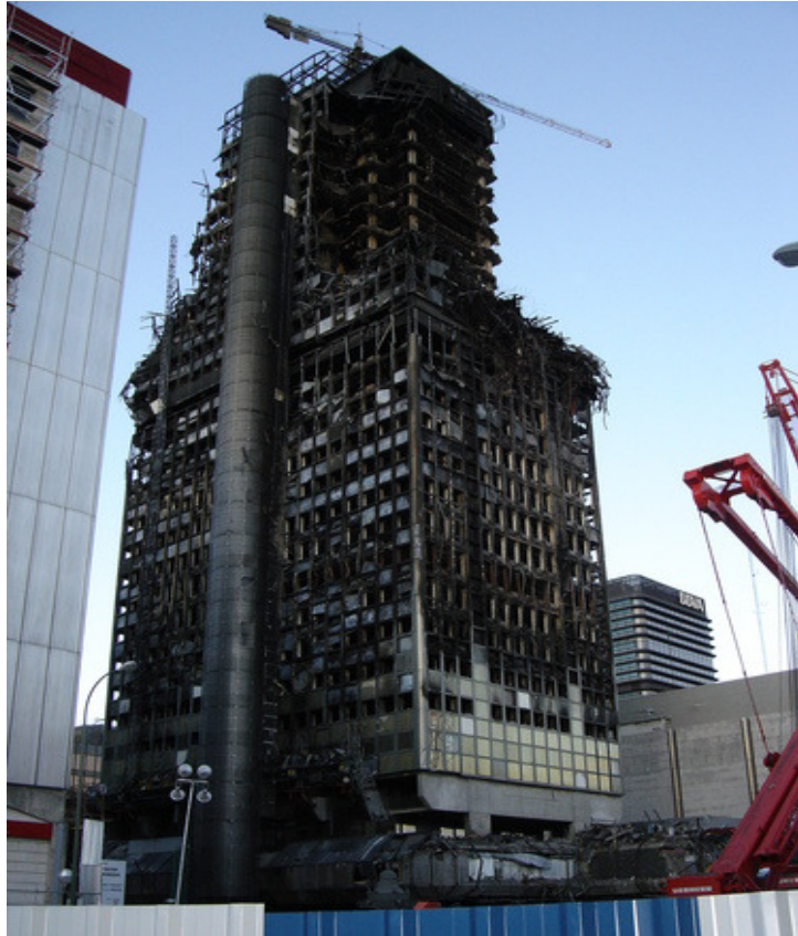
Figura 6.3: Torre Windsor após o incêndio (Wikimédia Commons, 2005)
