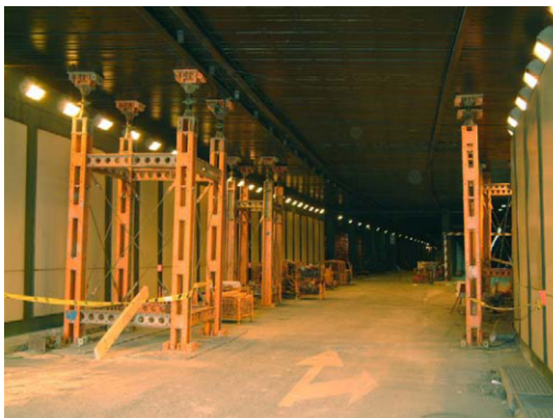
Figura 6.5: Colocação de estrutura de aço no subsolo para suportar a carga de um guindaste ao nível do solo (Ikeda K. e Sekizawa Ai, 2005)
