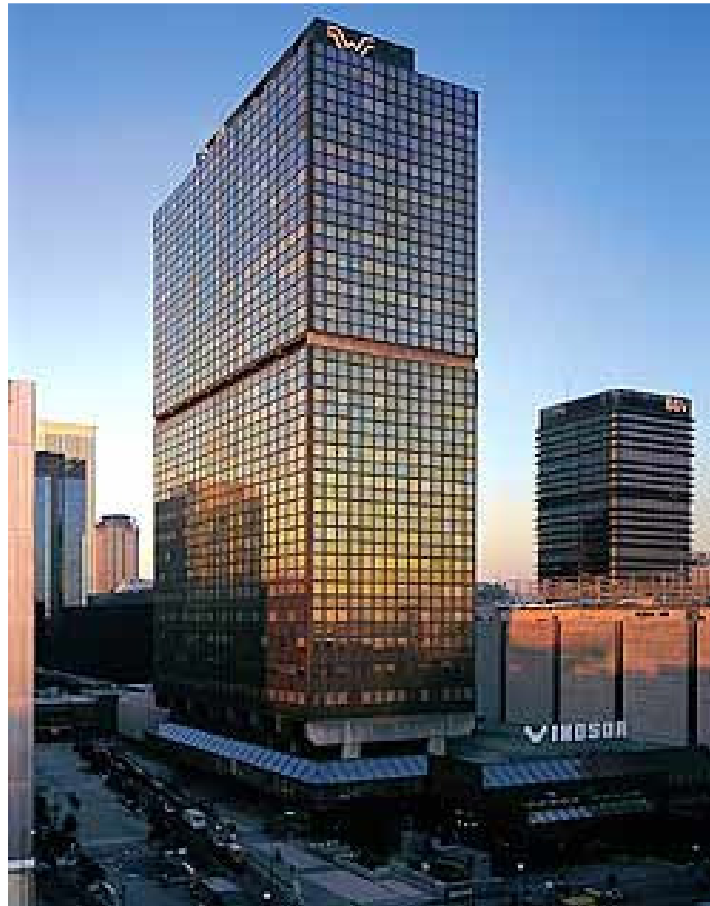
Figura 6. 2: Torre Windsor antes do incêndio (INTEMAC, 2005)
