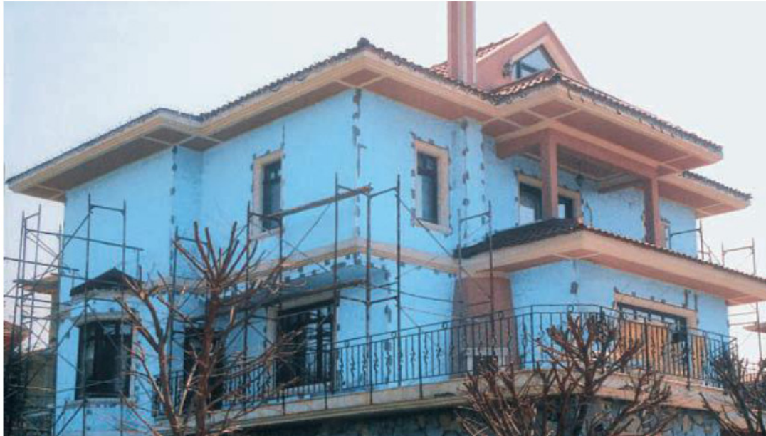
Figura 15 – Isolamento térmico pelo exterior; fonte: Valério, 2007.
