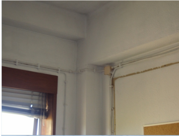
Figura 34 – Fotografia da ponte térmica analisada cunhal.
