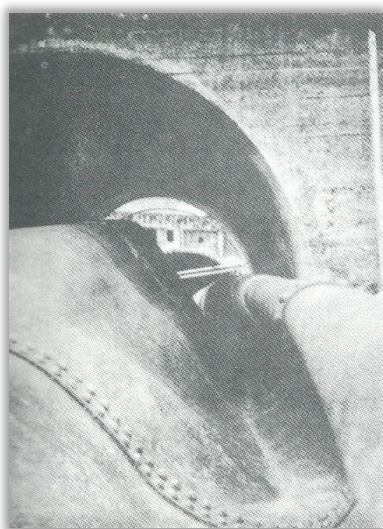
Figura 3.2. Conduto elevatória colapsada devido a depressão (Chaudhry, 1987)
