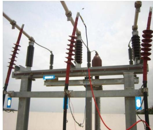
Figura IV-10Condutor de injeção de tensão ligado a extremidade do cabo
