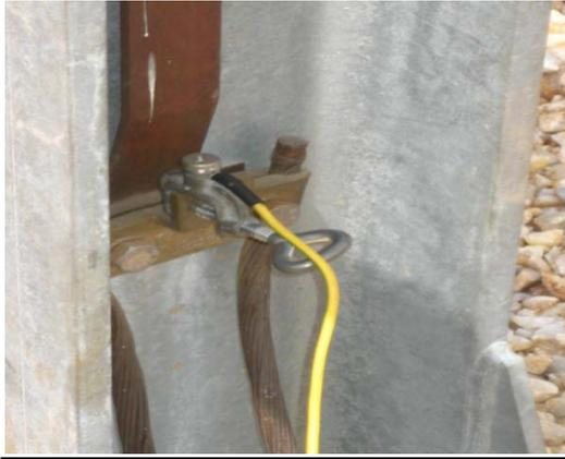
**Figura IV-11.condutor ligado a terra da subestação**
