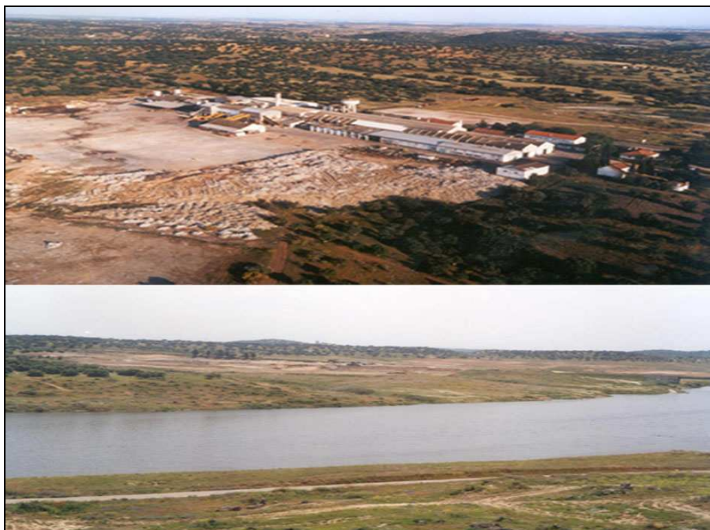
Figura II.1.12. As instalações da Portucel Recicla antes da intervenção e o resultado final desta.
