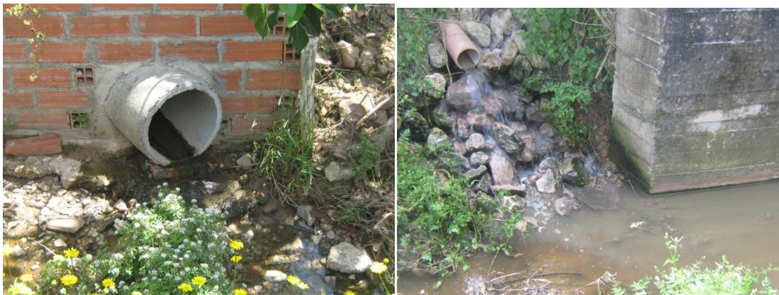
Figura 5.6 - Descargas pontuais identificadas ao longo do rio Alcabrichel
