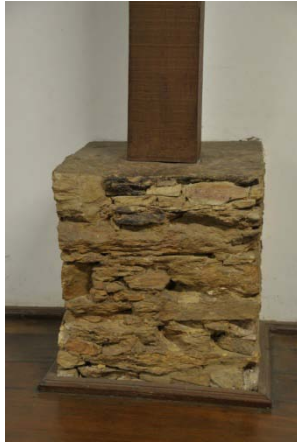
Fig. 83 – Salle de machines des théâtres de Bad Lauchstädt et Podestem, tous les deux en Allemagne. (K. D. REUS, M. LERNER, op.cit., pp.104 et 124.) et socle d’un pilier de la salle des machines du théâtre d’Ouro Preto.
