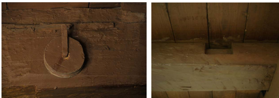
Fig. 89 – Roue conservée dans le soubassement du théâtre d'Ouro Preto et coupes/markes dans les poutres de sustentation de celui-ci. Photographies de Frederico Carvalho.
