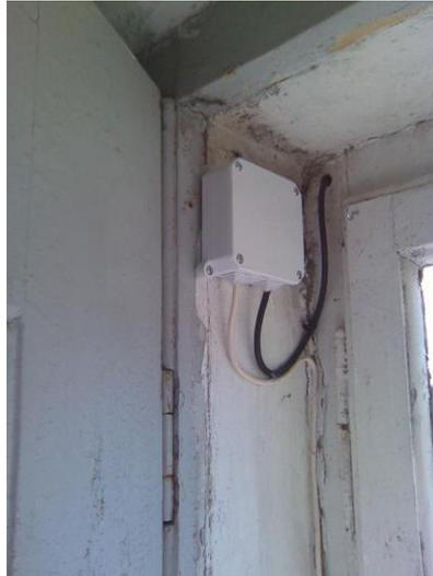
**Figura 4.11:** Foto ilustrativa do modo de falha *cabo descolado*
