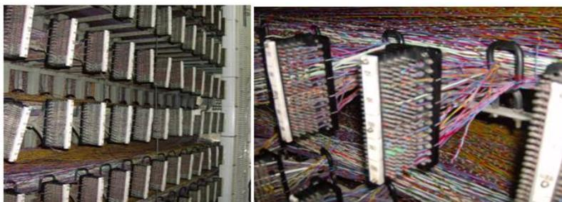
**Figura 4.14:** Fotos ilustrativas da causa *cabo desligado*
