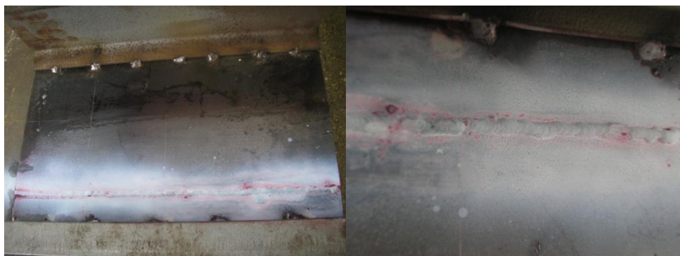
Figura 21 - Execução de Líquidos Penetrantes no cordão de soldadura
