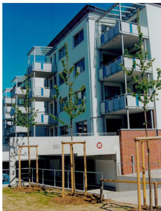
Figura 5: Kronsberg Siedlung - Edifício
