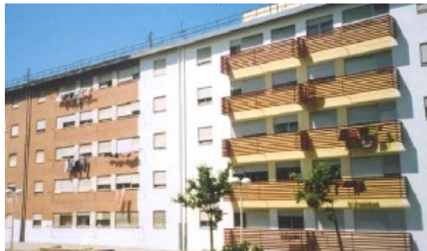
Figura 8.1 – Aspecto geral da fachada, antes (à esquerda) e depois (à direita) da intervenção de requalificação/conservação de edifícios no Bairro da Boavista, em Lisboa [88]
