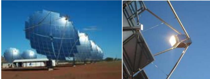
**9.15: PRATO HÉLIOSTATO CPV CS500, PORMENOR DO MÓDULO PV (SOLARPACES, 2008)**
