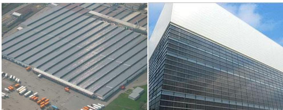
**9.2: BIPVS DE 5 MWP EM BÜRSTADT, ALEMANHA; (ESQUERDA) E 5,21 MWP EM KAMEYAMA, JAPÃO, NOTE-SE A UTILIZAÇÃO DE PAINÉIS TRANSPARENTES NA FACHADA DO EDIFÍCIO; (DIREITA) (SANYO SOLAR, 2009)**
