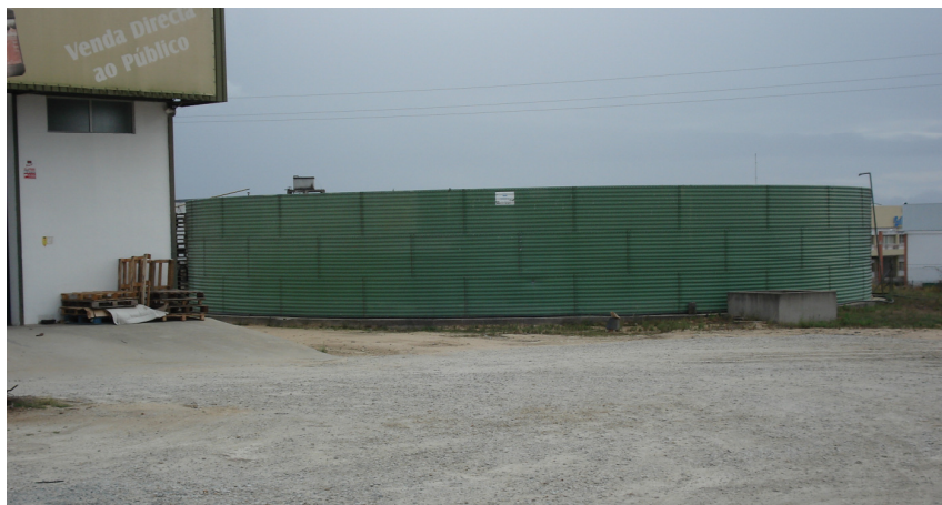
Figura 7-4 – Tanque de Armazenamento das Águas Ruças
