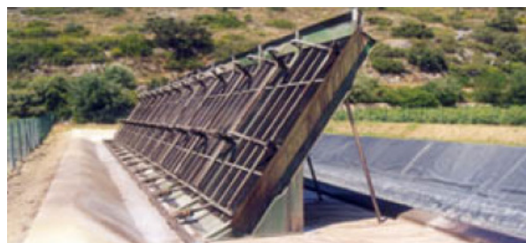
Figura 5-3 – Painéis de Evaporação
