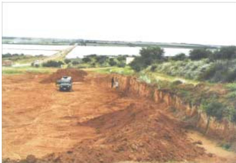
Figura 5.18. Bajo de Giuliani, vista de las obras del acueducto
