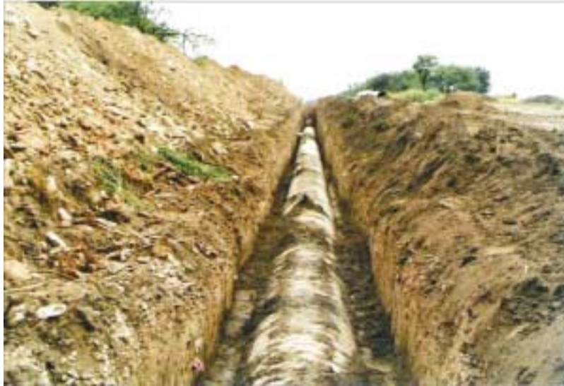
Figura 5.19. Vista de la traza del acueducto en pendientes altas
