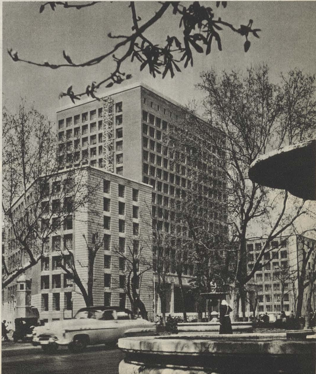
La Delegación Nacional de Sindicatos está terminando esta soberbia edificación en el paseo del Prado. Junto a la fuente antigua y caprichosa, cerca de la pinacoteca magnífica, la teoría de ventanas ofrece albergue capaz para incontables trabajos.
