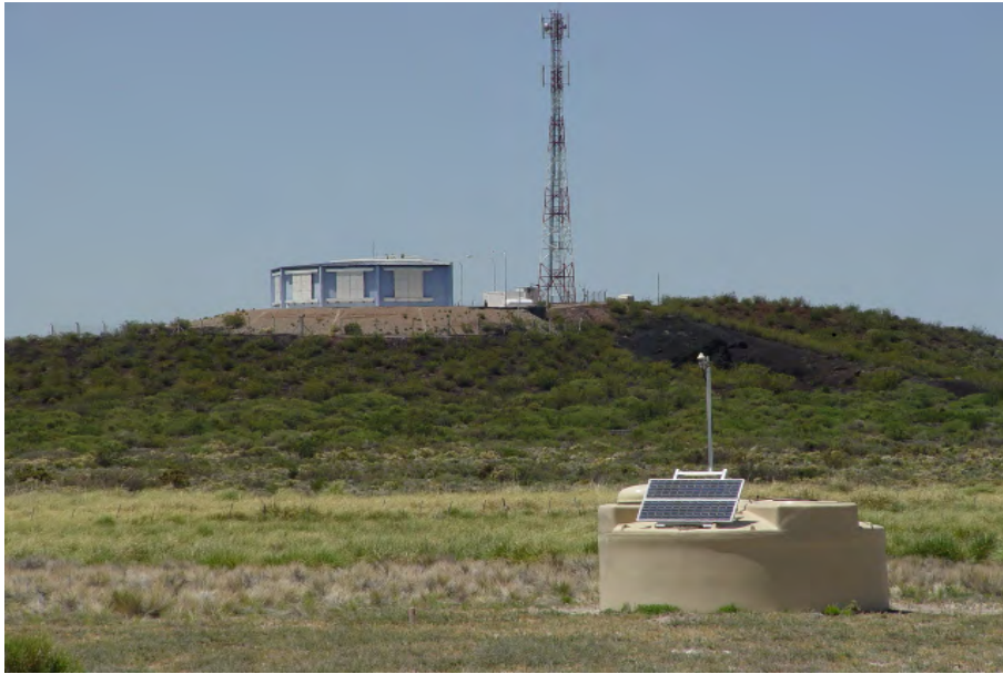
Figura 2.4: Fotografía del edificio de la estación FD Los Leones, con una estación SD y la torre de comunicaciones.
